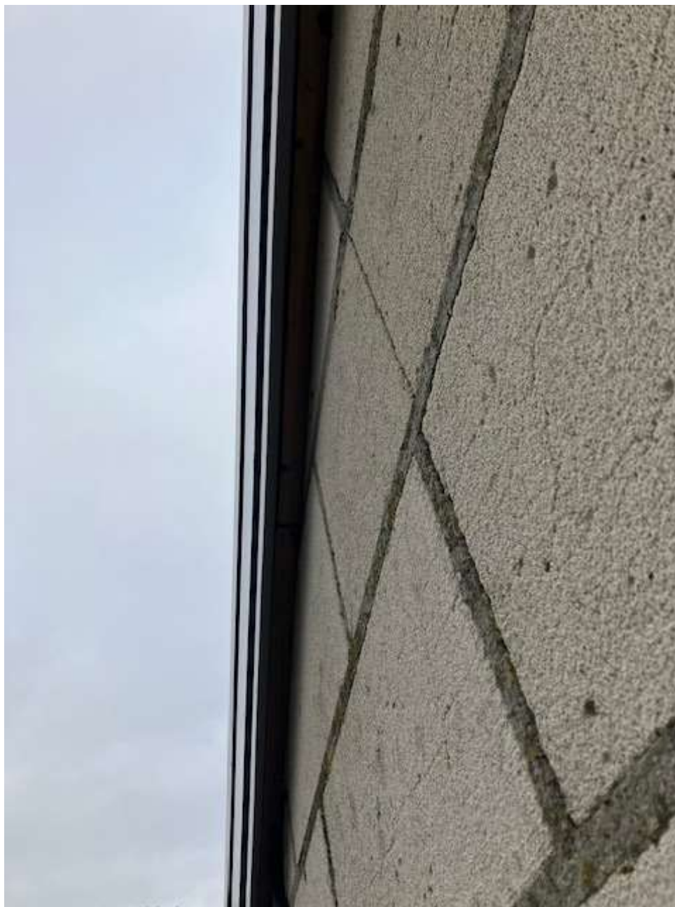
• Afbeelding 9: Detail dakrand bij achtergevel
