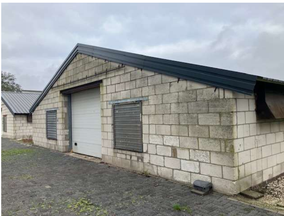
• Afbeelding 7: Achterzijde te slopen stal
