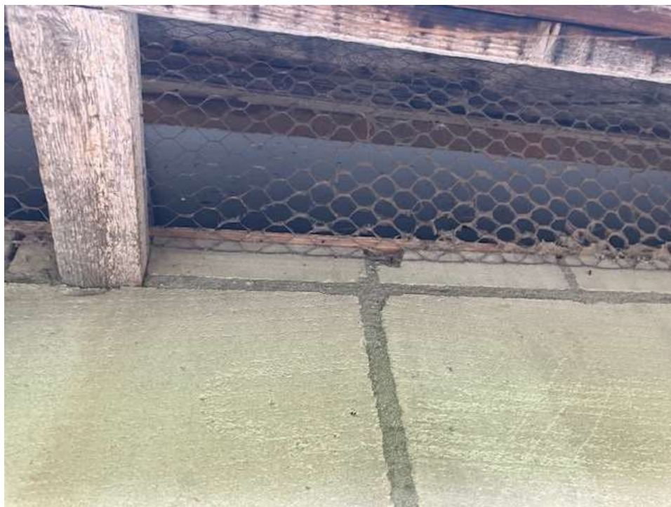
• Afbeelding 5: luchtinlaat met vogelgaas dicht gezet
