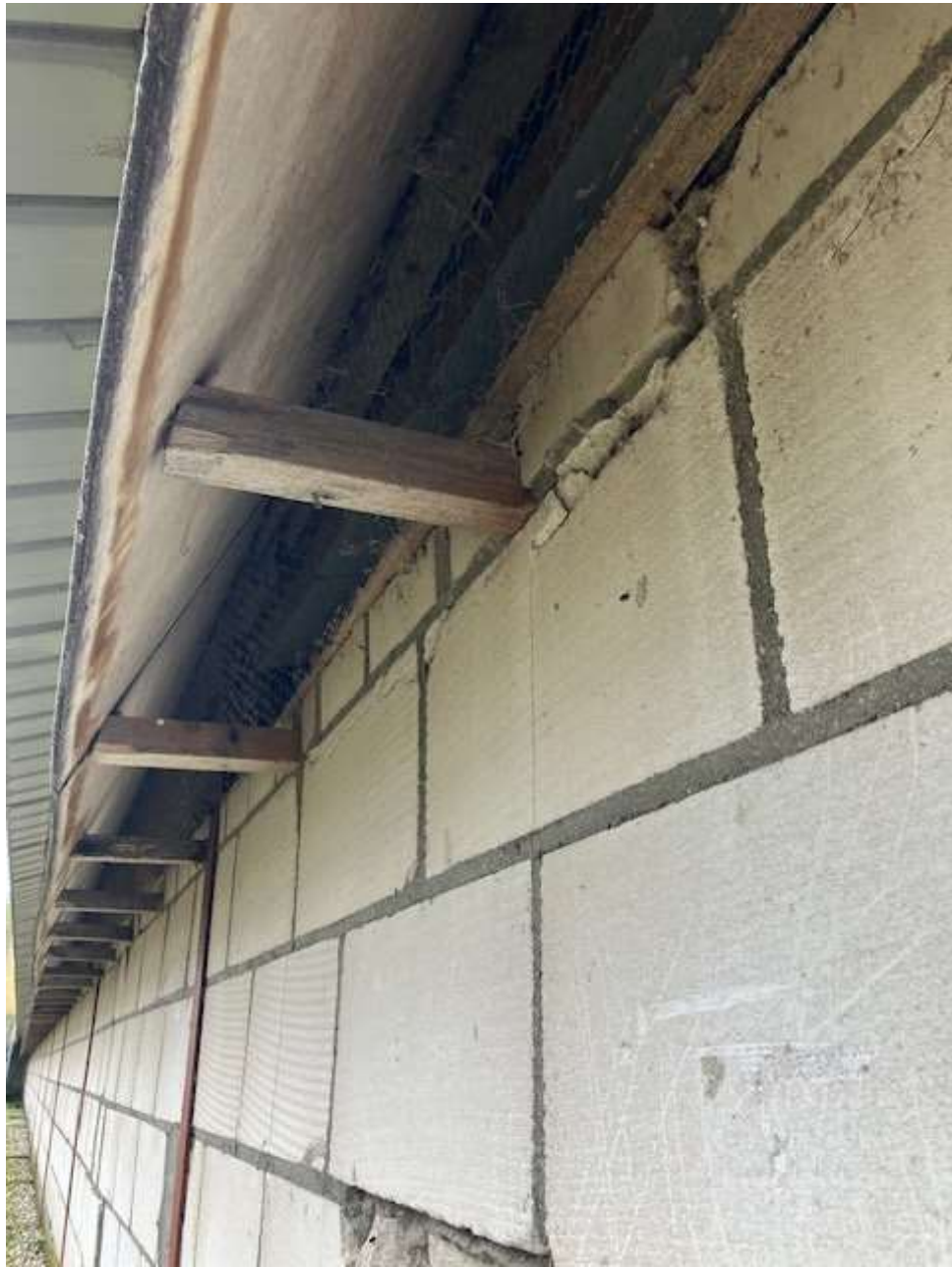
• Afbeelding 13: onderzijde dak, ecopanelen, luchtinlaat met vogelgaas dichtgezet
