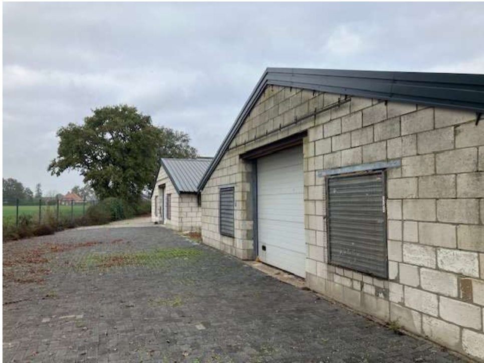
• Afbeelding 8: achterzijde te slopen stal
