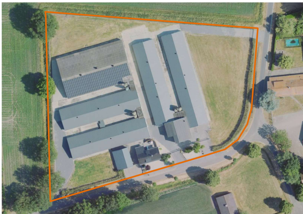
● Afbeelding 2: luchtfoto detail plangebied (bron: streetsmart.cyclomedia.com/streetsmart , geraadpleegd op 12/11/2024)
