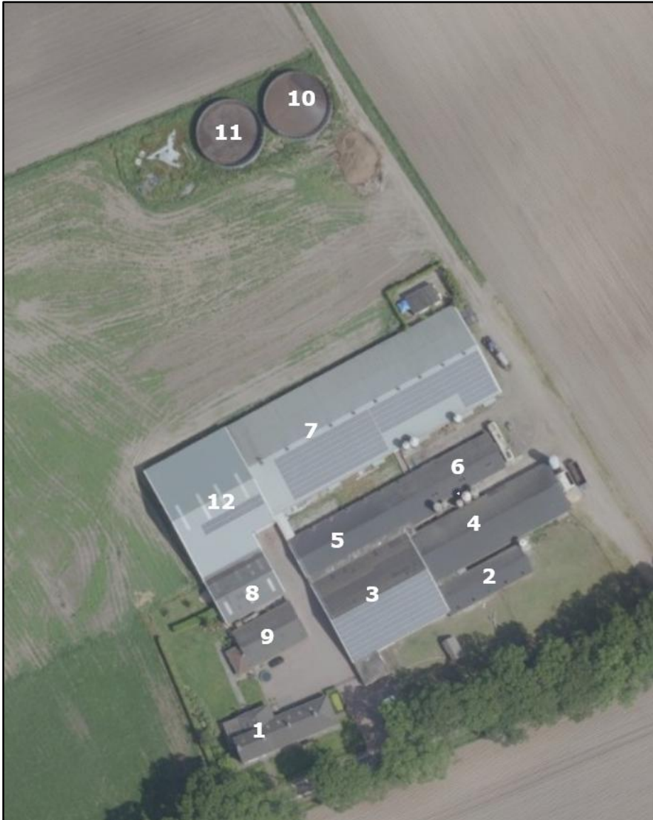
Afbeelding 9 Luchtfoto huidige situatie plangebied
