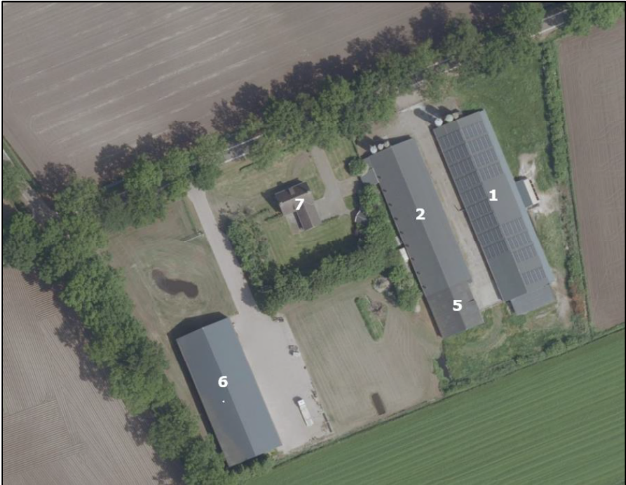
Afbeelding 8 Luchtfoto huidige situatie plangebied
