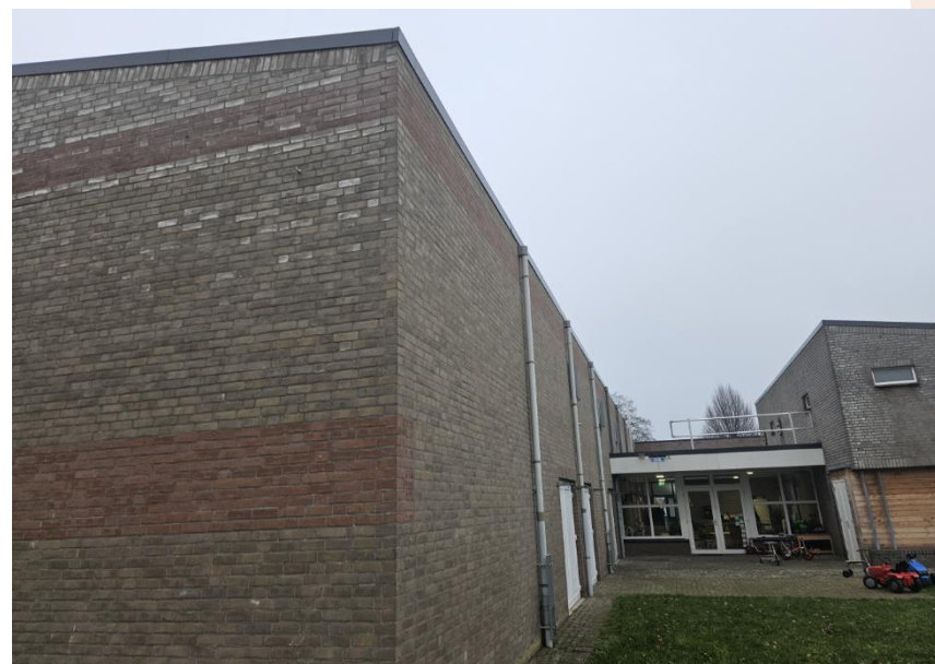
Figuur 5: Centraal gelegen aangrenzend gebouw plangebied
