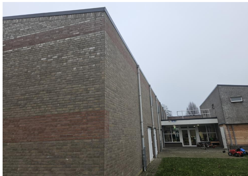
Figuur 8: Centraal gelegen aangrenzend gebouw plangebied
