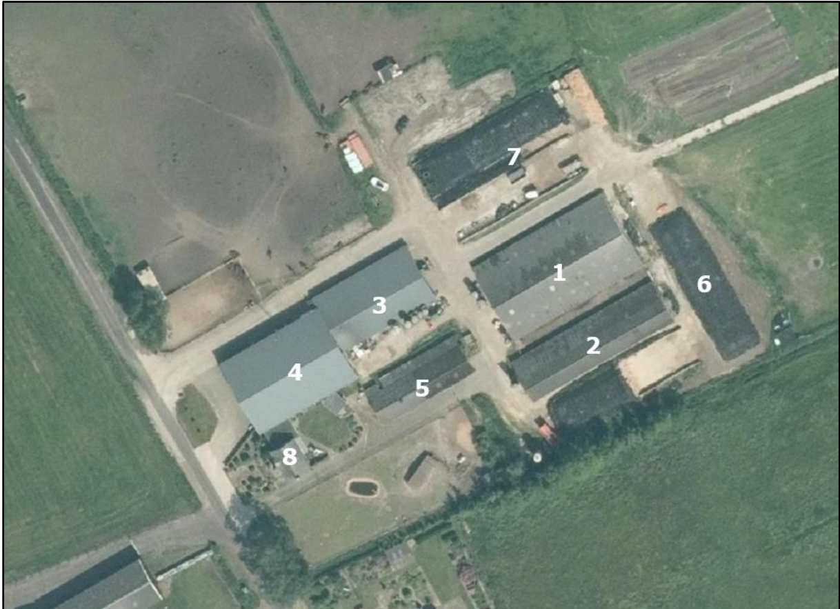
Afbeelding 3. Luchtfoto huidige situatie plangebied.
