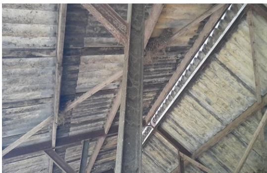
Foto 15. Open koeienschuur (4). Dak.
