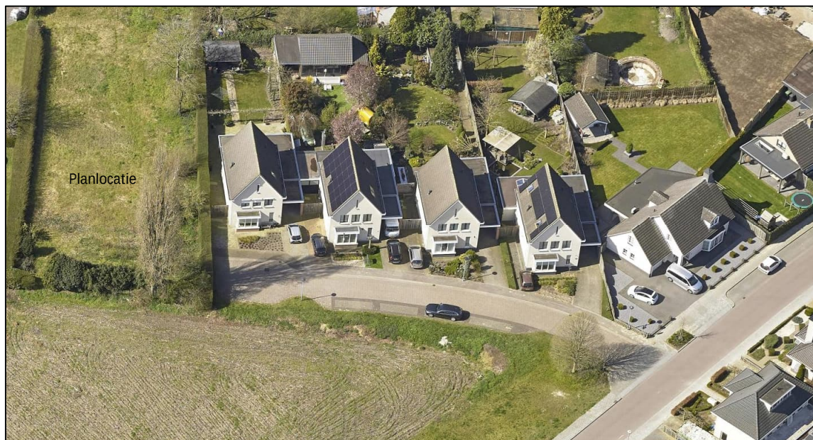
Figuur 10: Luchtfoto met de planlocatie, gelegen aansluitend aan bestaande woningen die zijn gerealiseerd aan (een insteekweg) de Tramweg
