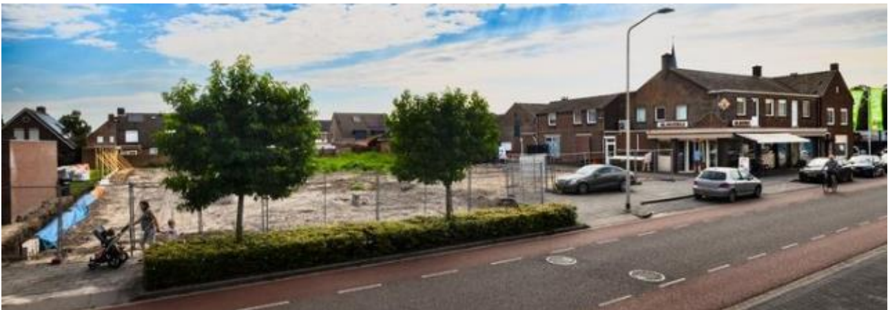
Figuur 3: Projectgebied gezien vanaf de Zeilbergsestraat, met deel van het plangebied reeds gesloopt
