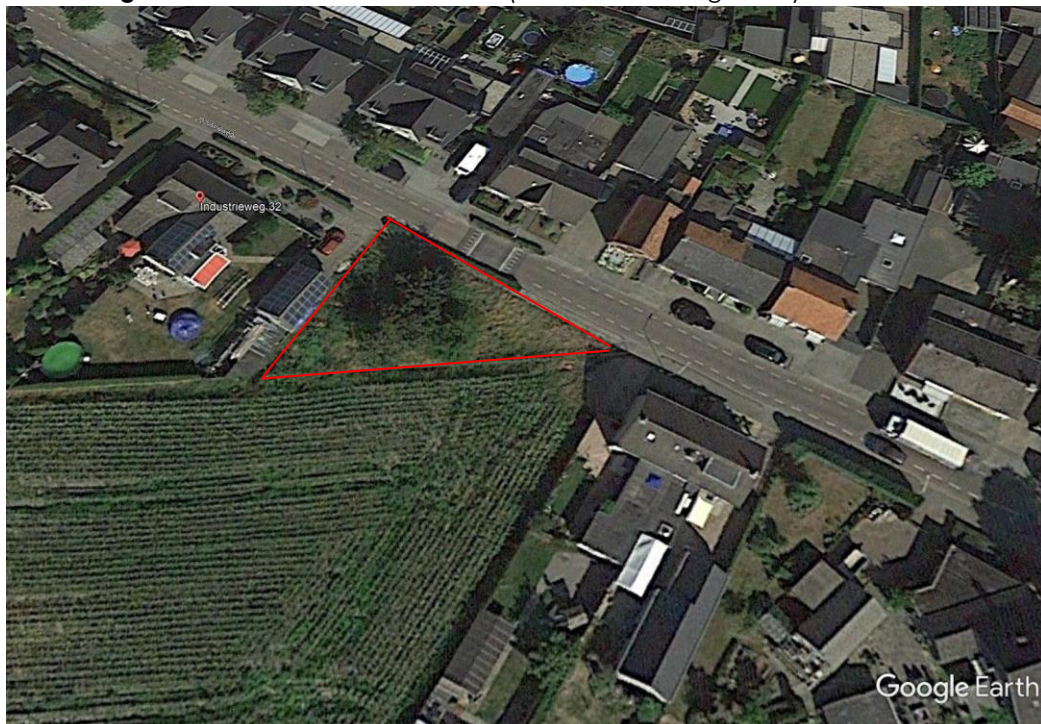
Afbeelding 1: Luchtfoto onderzoekslocatie (rood omkaderd gebied)
