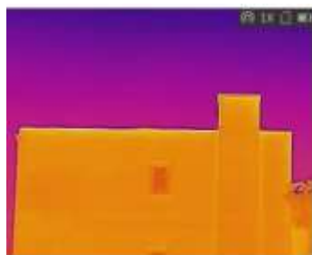
Figuur 8a: Warmtebeeld gevel.
