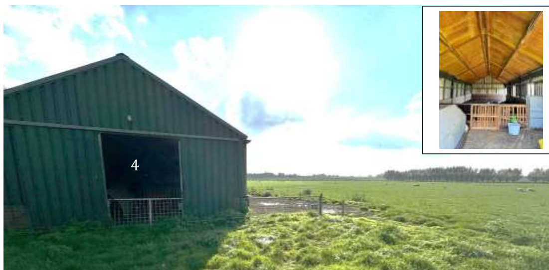
Figuur 39c: Schapenschuur op korte afstand westelijk van de bezette nestkast aan buiten het plangebied gelegen Grote Bottel 6. Zie nr. 4 in de luchtfoto.
