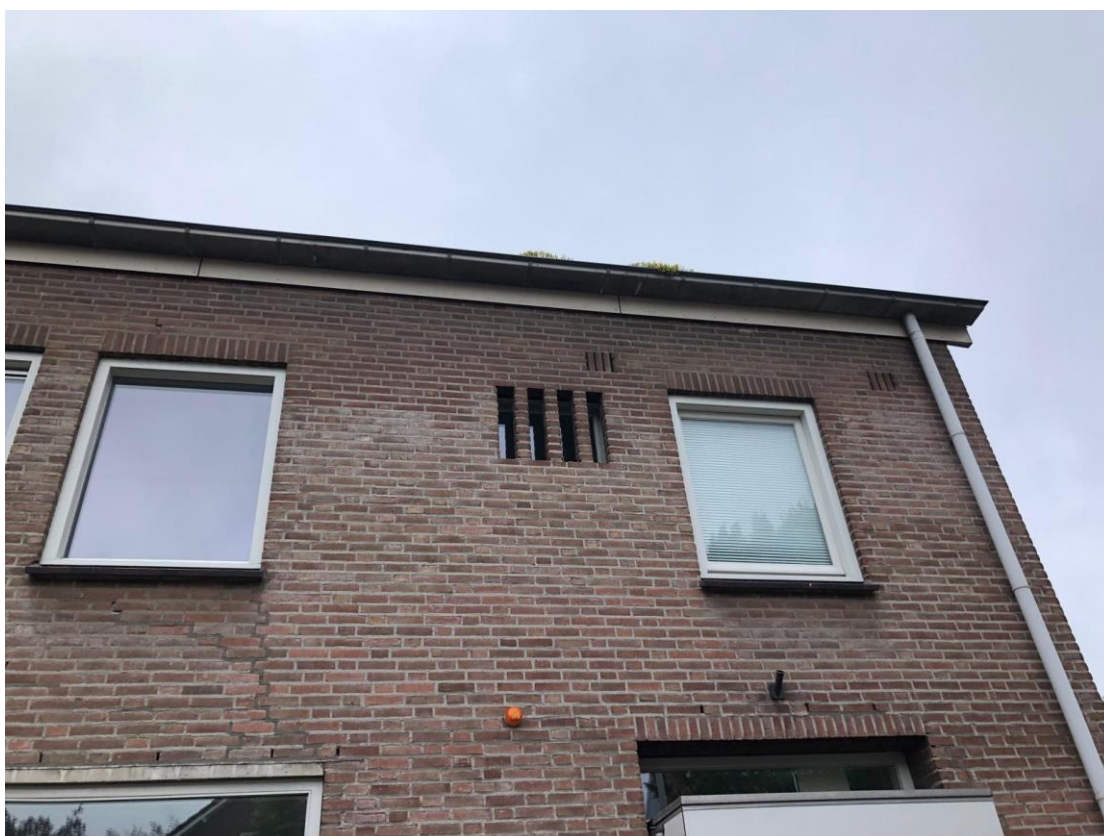
Figuur 26a: Open structuren van de buitenste muur van gebouw 120. Achter deze open structuren heeft een inspectie van de spouw plaatsgevonden. Er zijn géén sporen van vleermuizen, zoals mest of prooiresten, aangetroffen. De spouw is tochtig door de verschillende open structuren en derhalve niet geschikt als verblijfplaats voor vleermuizen.
