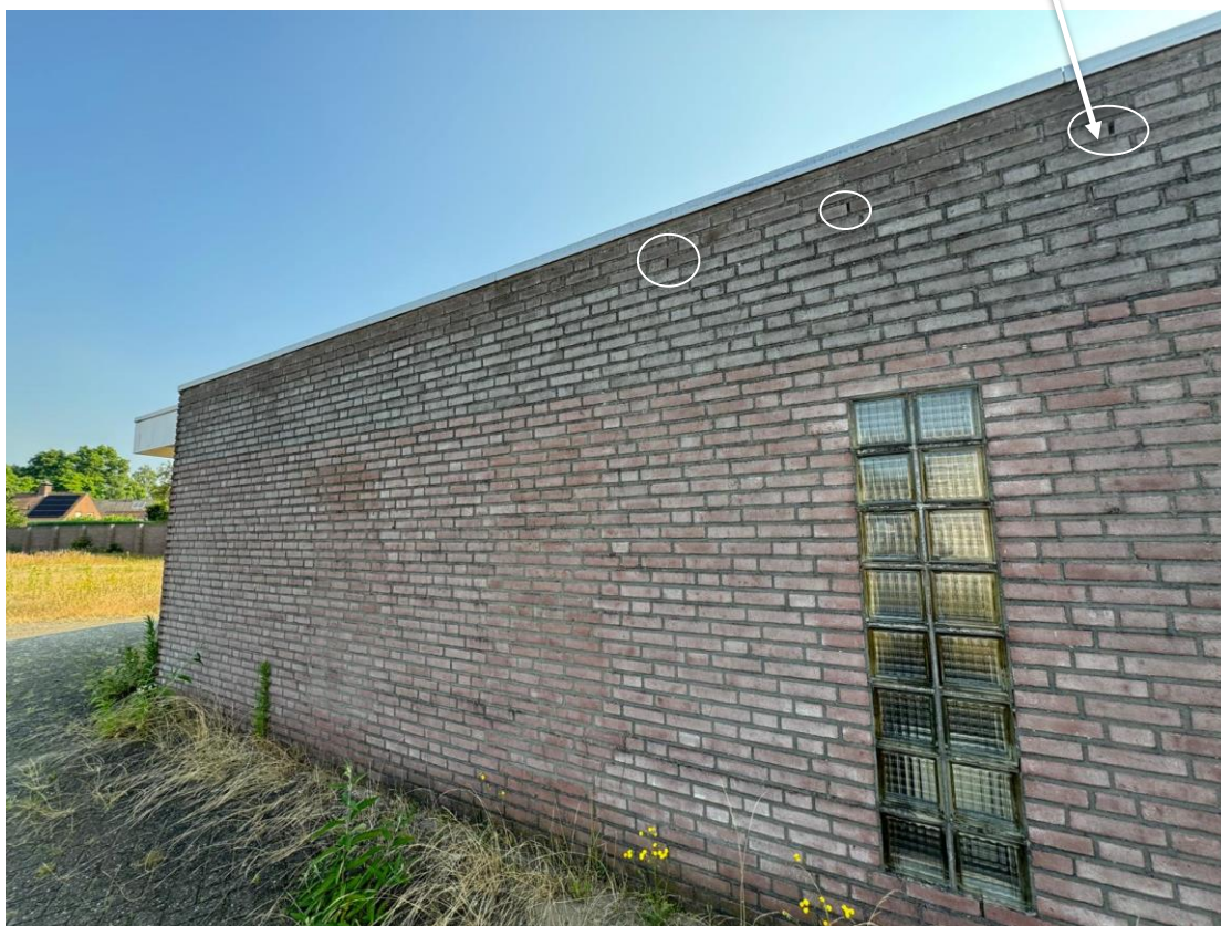
Figuur 25c: Kantooruitbouw achter gebouw 120 (Stationsstraat). Hier zijn openstootvoegen aanwezig maar deze zijn met gaas afgedicht.
