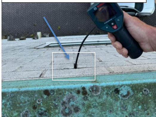
Figuur 25a: Interne inspectie Gebouw 122.
