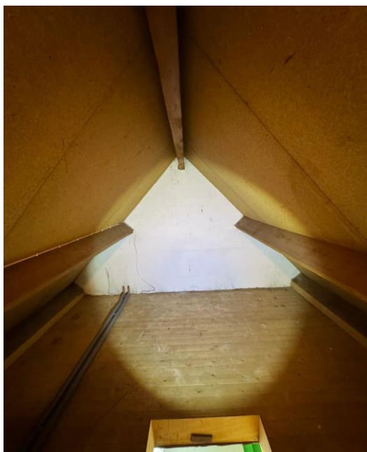
Figuur 26d: Inspectie Zolder gebouw 120a
