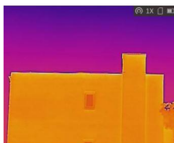
Figuur 7a: Warmtebeeld gevel
