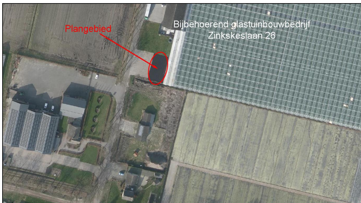
Foto bestaande situatie
