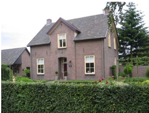
Helenastraat 16, voormalig kantoor Maatschappij Helenaveen
