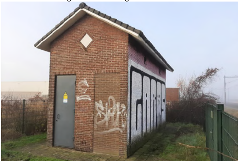
Figuur 2-2: Foto van huidig schakelstation (bron: Ecogroen, januari 2022)
