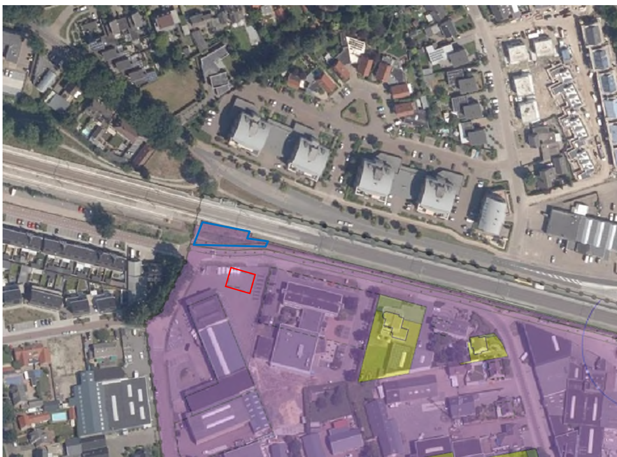
Figuur 6-1. Luchtfoto met blauwe arcering zijnde projectlocatie, en rode arcering zijnde geprojecteerde bedrijfswoning.
