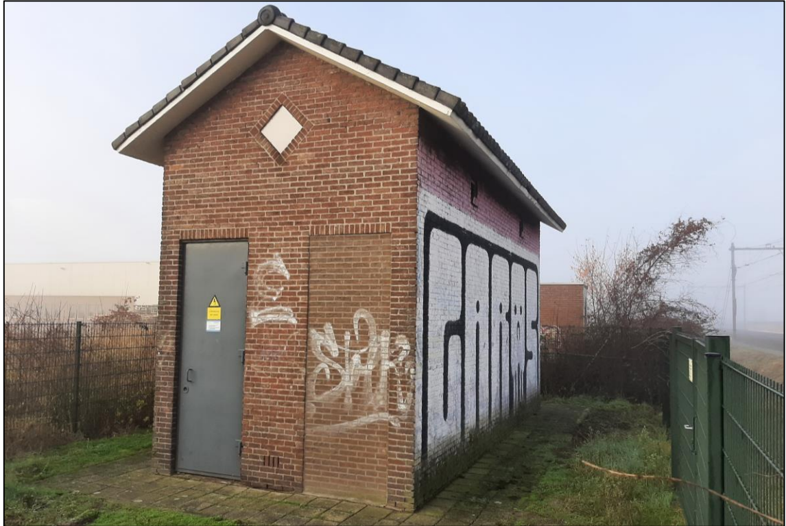
Figuur 1.2 Impressie van het te slopen schakelstation. Bron foto: Ecogroen.
