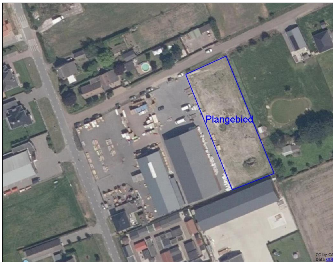
Foto bestaande situatie
