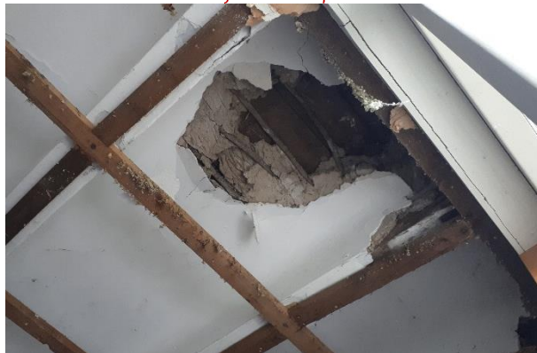
Plafond uit de bouwtijd in de opkamer.
