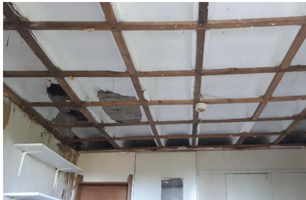
Plafond uit de bouwtijd in de opkamer.
