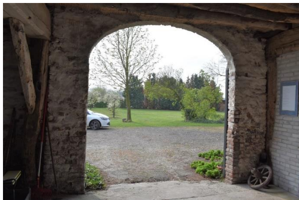
Opening voor de deel deur in het bedrijfsgedeelte.
