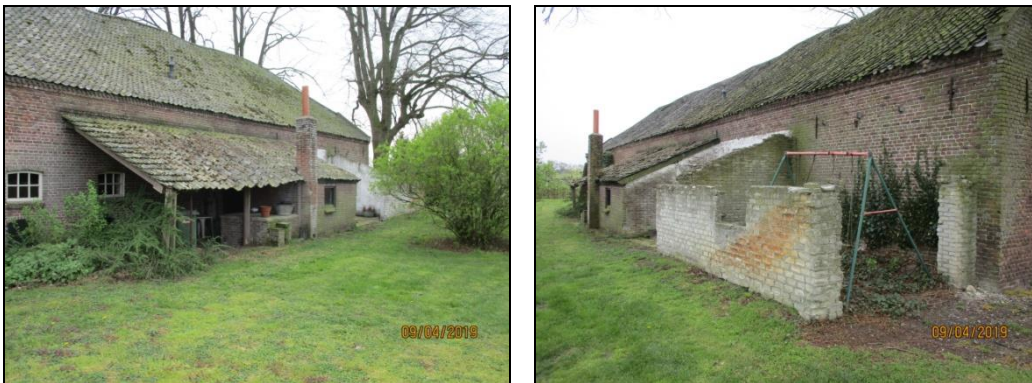
Aanbouw en restanten van een aanbouw langs de noordgevel
