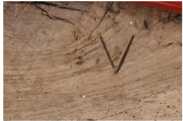
Detail telmerk V in het bedrijfsgedeelte.
