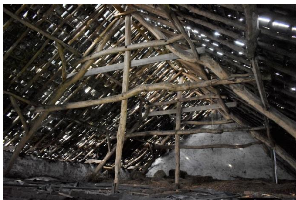
Zolder boven bedrijfsgedeelte.
