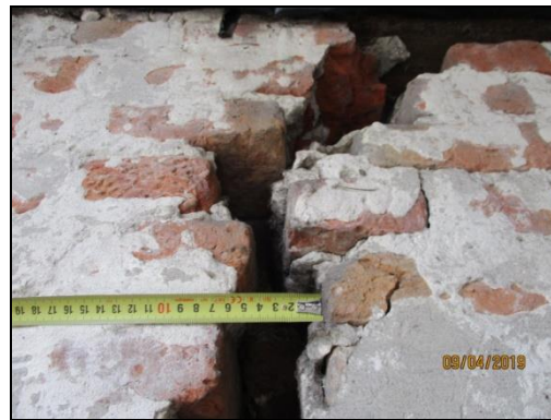
Scheur dragend metselwerk
