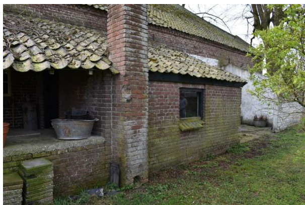
Aanbouw tegen achtergevel.
