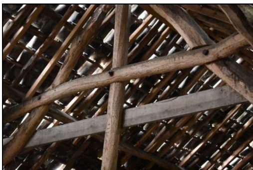
Spant dakconstructie
