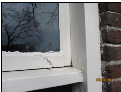
Schilderwerk houten deurkozijn
