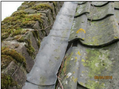
Loodaansluiting pannendak op zijgevels
