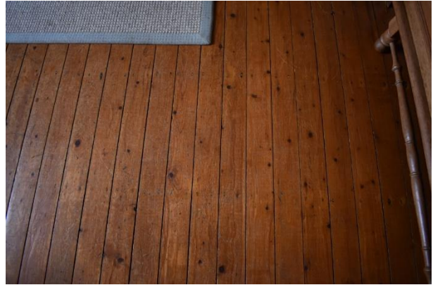
Houten vloer in woonkamer.
