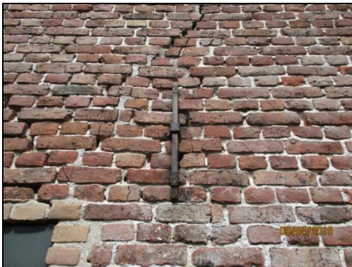
Ontbrekend schilderwerk smeedijzeren balkankers
