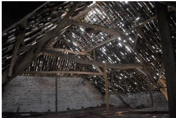
Zolder boven het bedrijfsgedeelte.
