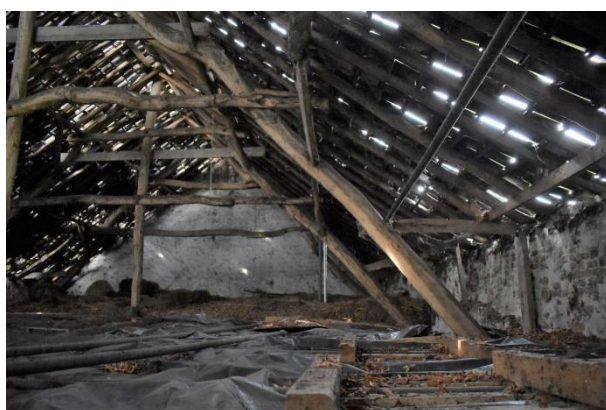
Zolder boven bedrijfsgedeelte.
