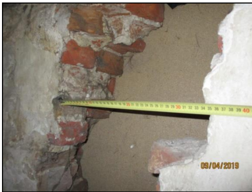
Scheur dragend metselwerk
