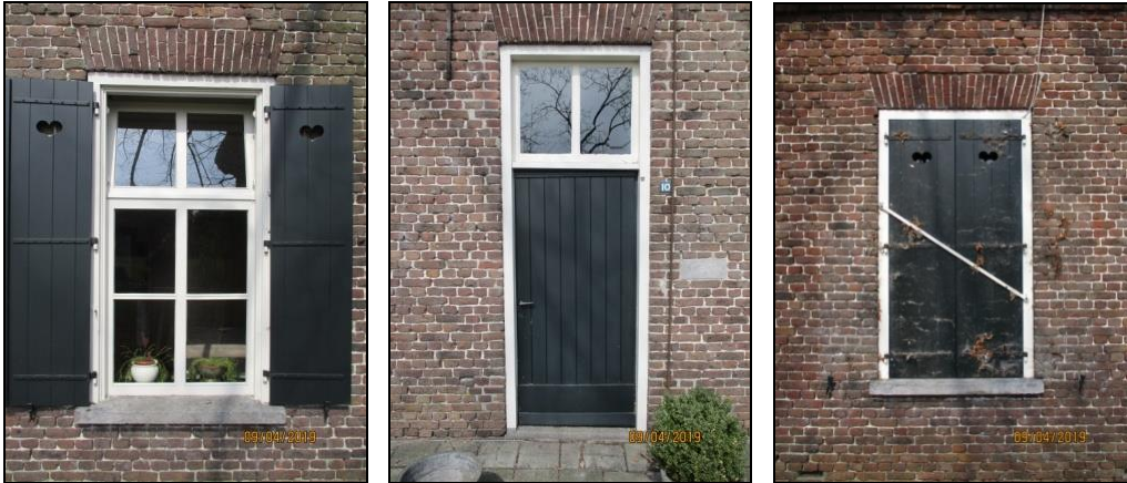
Houten gevelkozijnen voordien van ramen, deur en luiken
