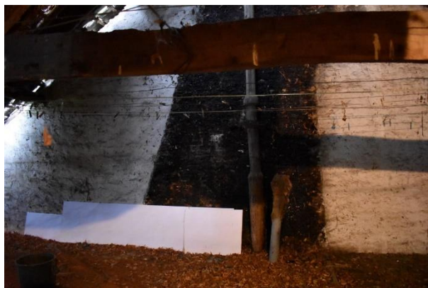
Brandmuur met aftekening schoorsteen.
