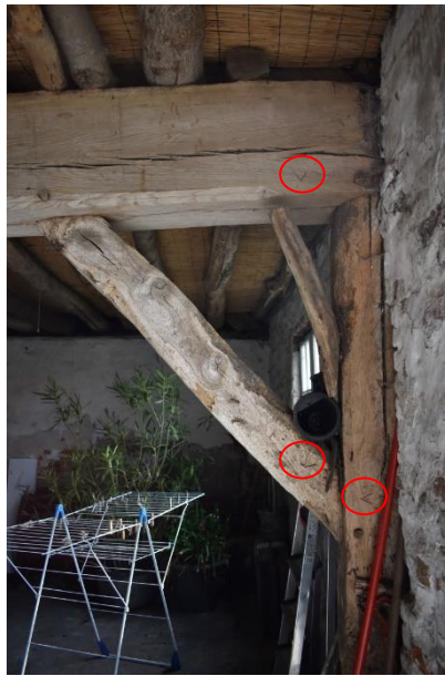
Moerbalk op staander in bedrijfs- gedeelte met telmerk V.
