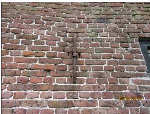
Smeedijzeren balkanker, geoxideerd
