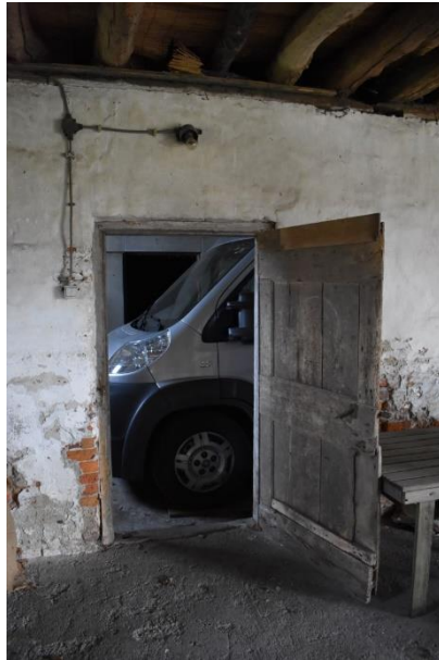
Paneeldeur tot de ruimte met koelcel in bedrijfsgeboude.
