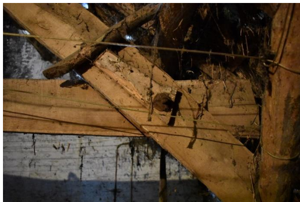
Spantconstructie op zolder.
