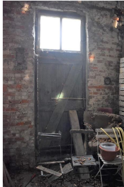
Opgeklampte deur in achtergevel.
