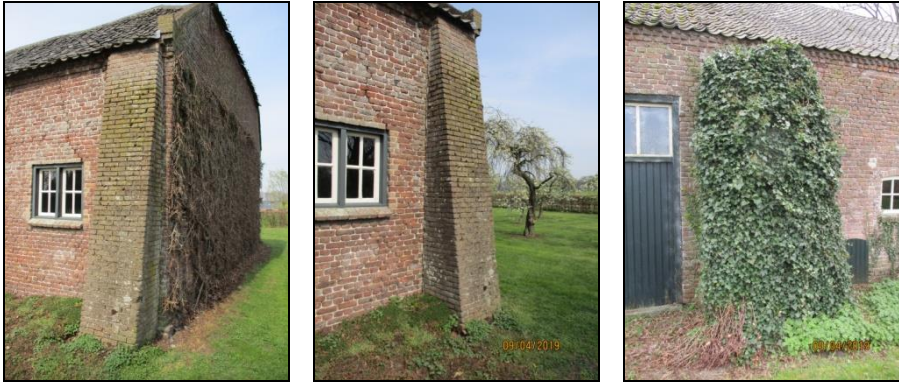
Steunberen gemetseld tegen de noord- en zuidgevel
