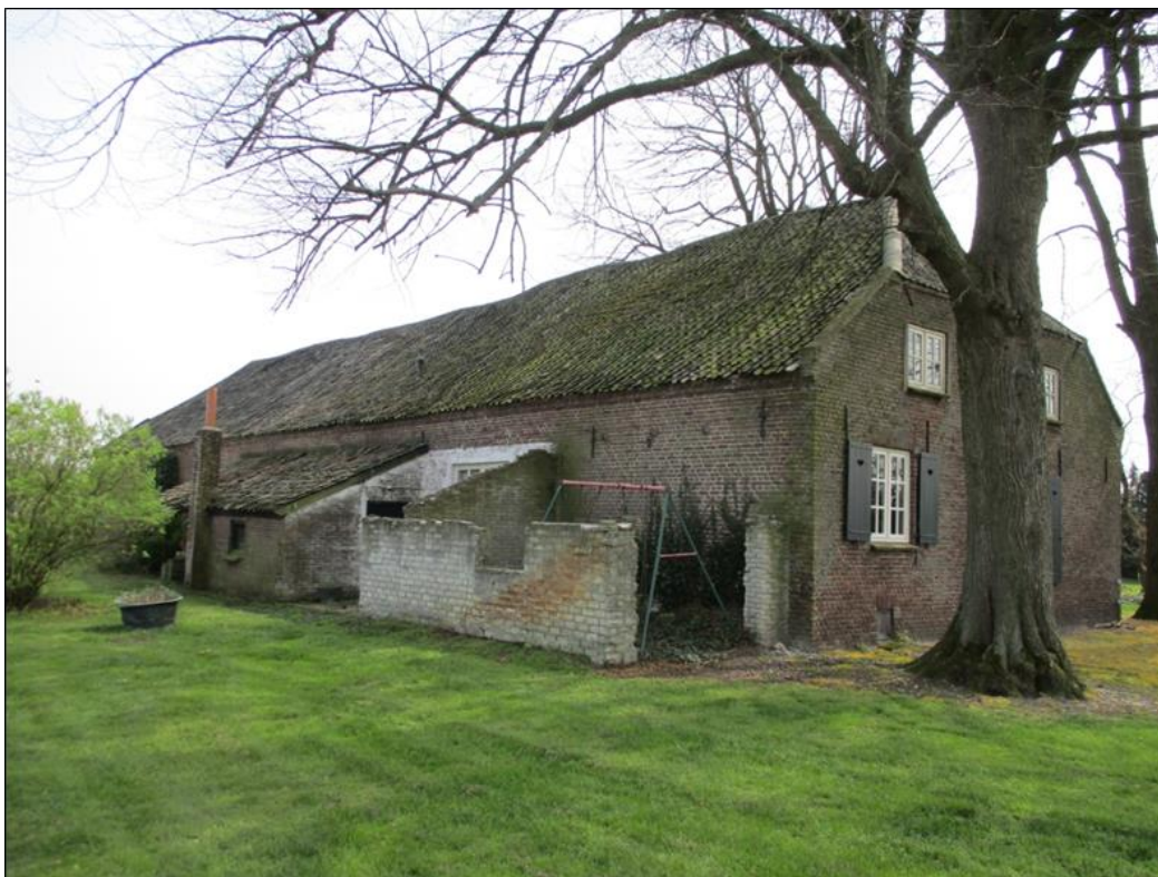
Noord- en westgevel
