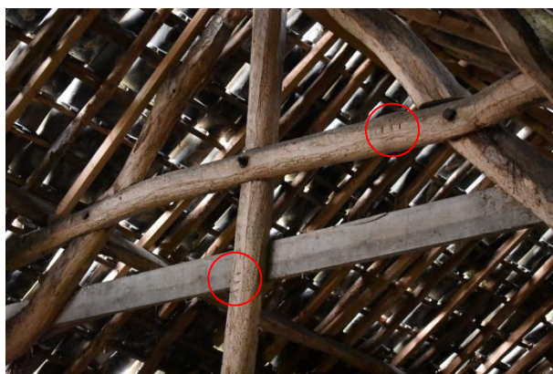
Spant met telmerken III boven het bedrijfsgedeelte.
