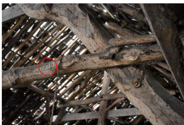
Spantconstructie boven bedrijfsgedeelte met telmerk III.
