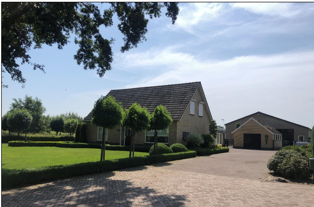
Afbeelding 2. Huidige, te slopen bedrijfswoning Voorpeelweg 22 Deurne
