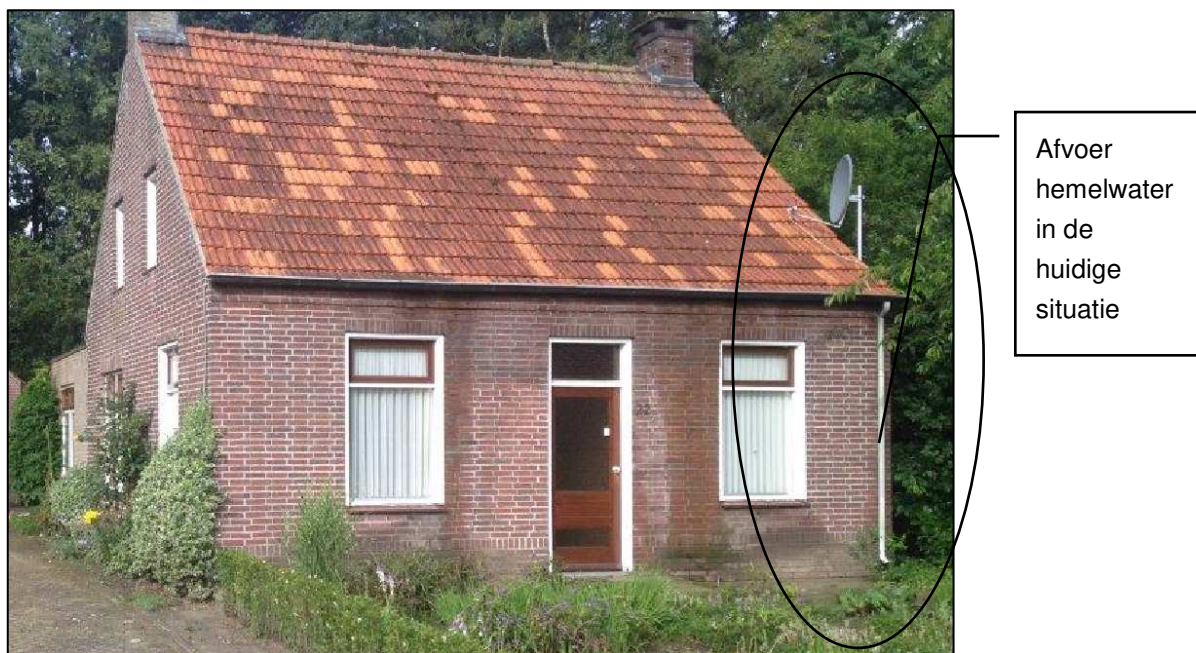
Figuur 15: Foto van hemelwaterafvoer in de huidige situatie
