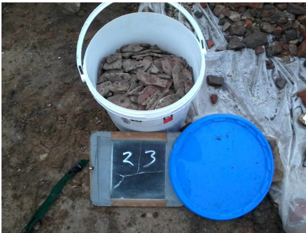
Foto 45. Asbestverdacht materiaal sleuf 23
