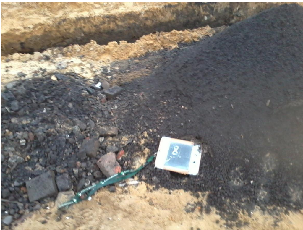
Foto 18. Opgegraven materiaal sleuf 08
