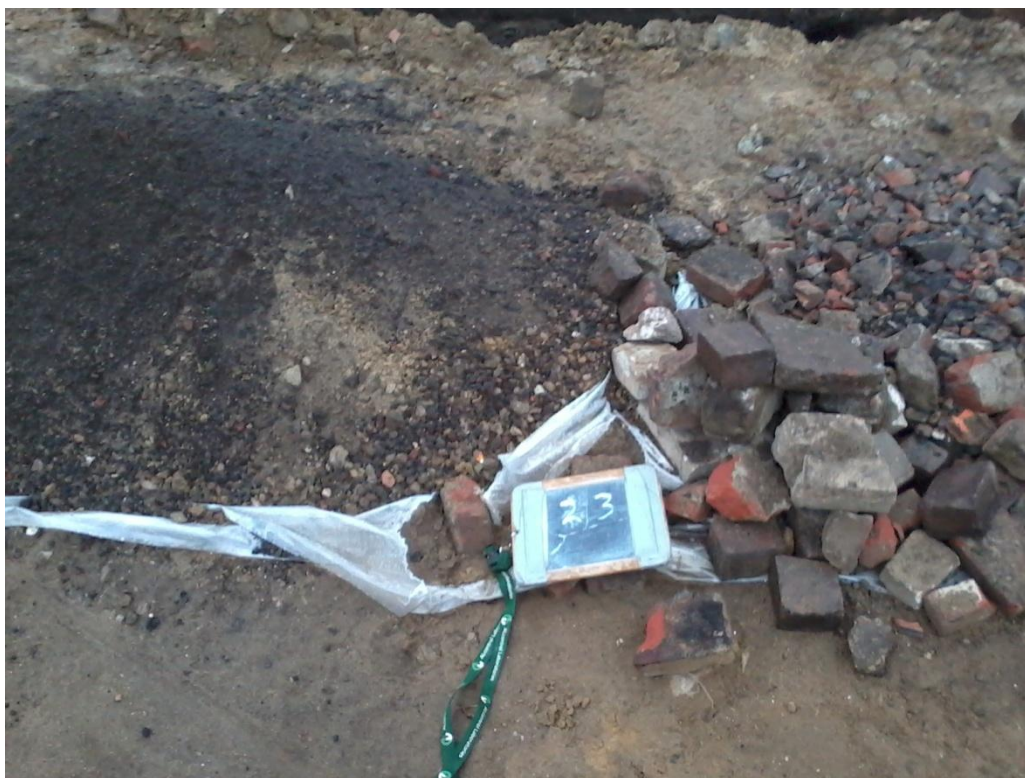
Foto 44. Opgegraven materiaal sleuf 23
