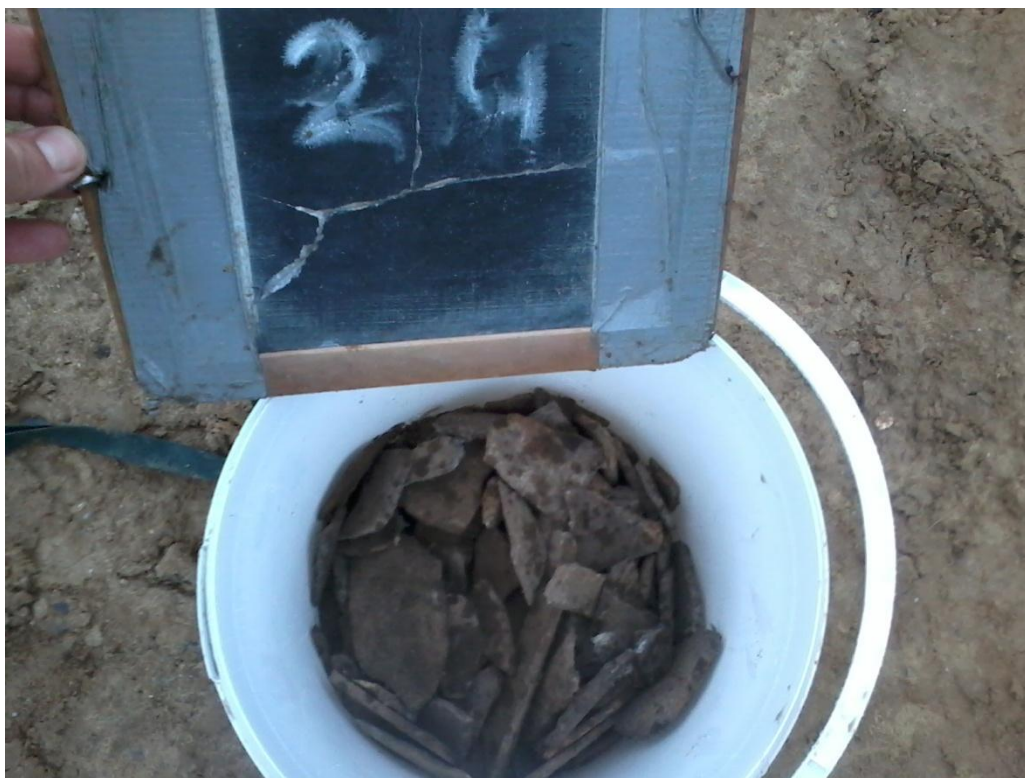
Foto 48. Asbestverdacht materiaal sleuf 24
