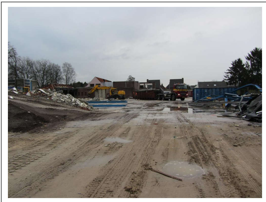
Foto 2. Onderzoekslocatie d.d. 11 april 2013 ten tijde van de sloop
