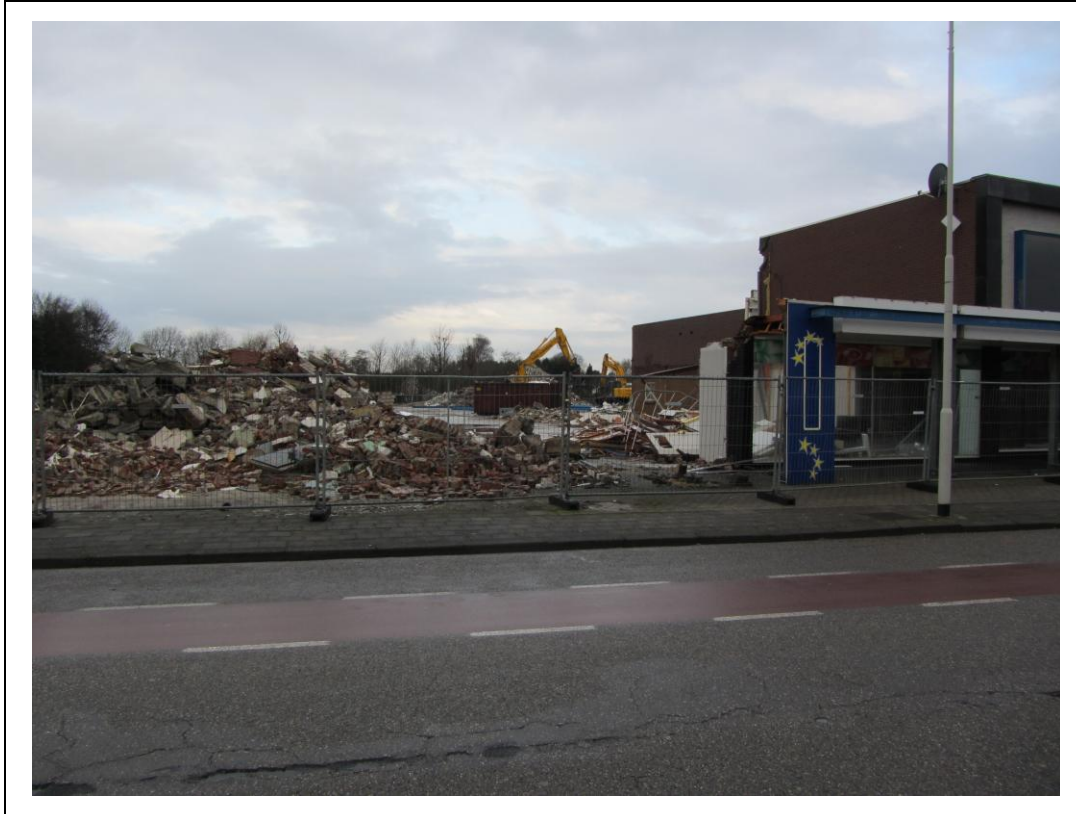
Foto 1. Onderzoekslocatie d.d. 11 april 2013 ten tijde van de sloop
