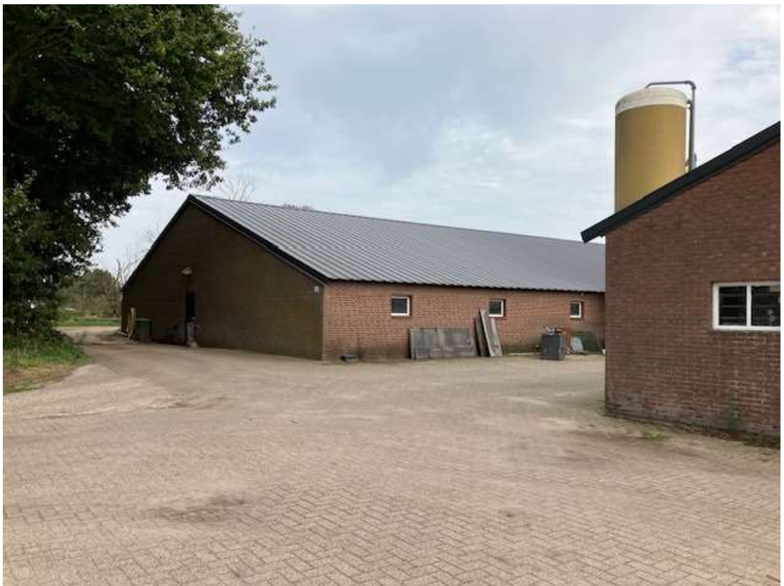
• Afbeelding 13: Te slopen varkensstallen aan de achterzijde
