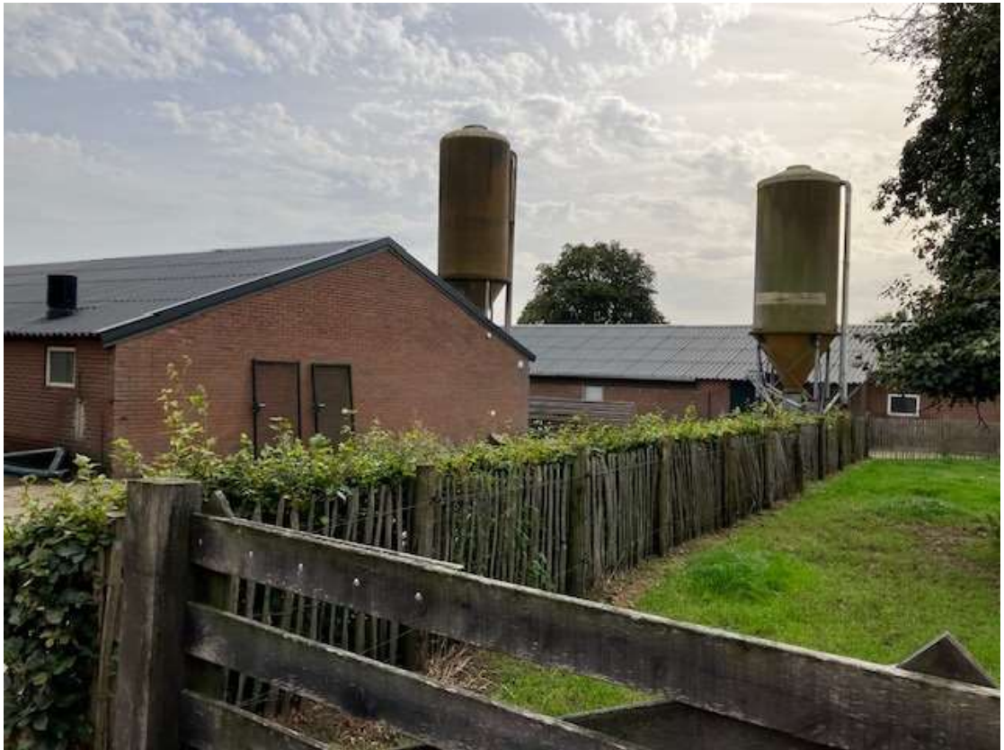
• Afbeelding 12: Varkensstallen die gesloopt worden met siertuin
