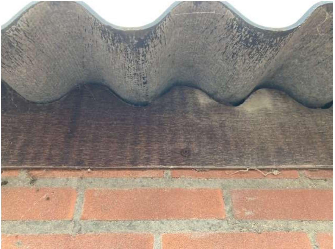
• Afbeelding 17: Vogelschroot golfplaten
