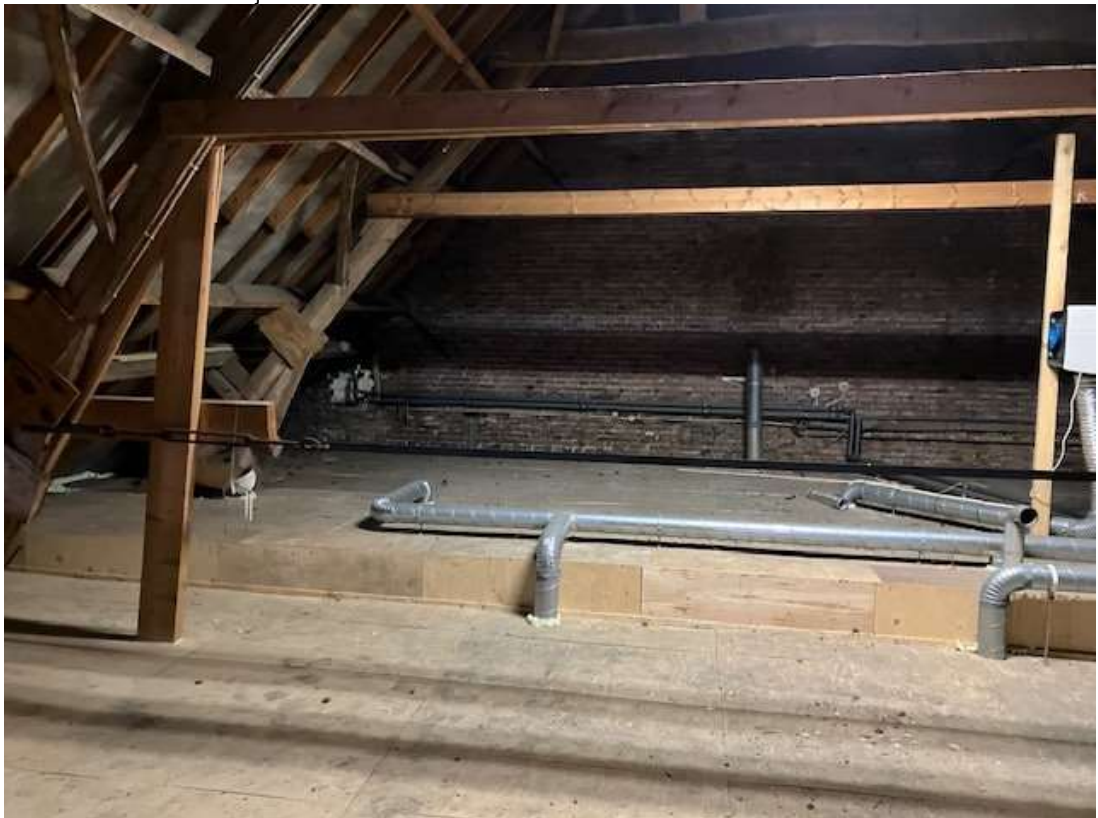
• Afbeelding 5: Zolder van de te verbouwen boerderij.
