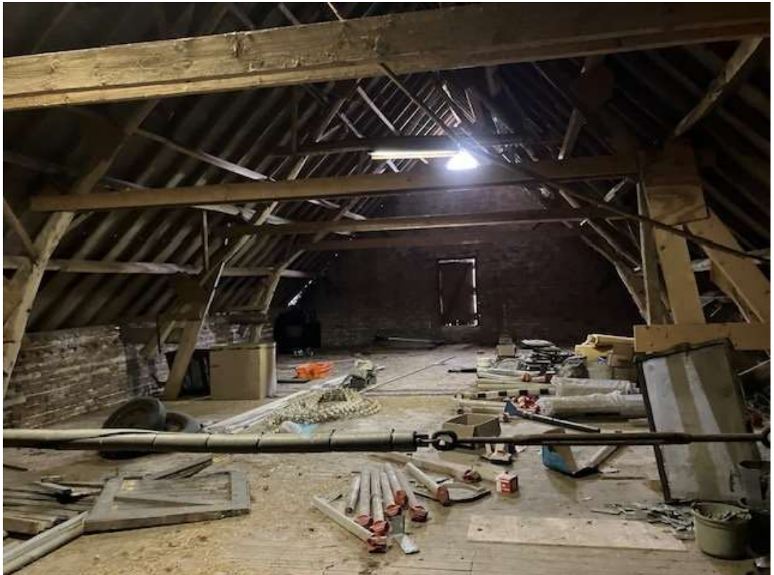
• Afbeelding 6: Kap boven het schuurgedeelte
