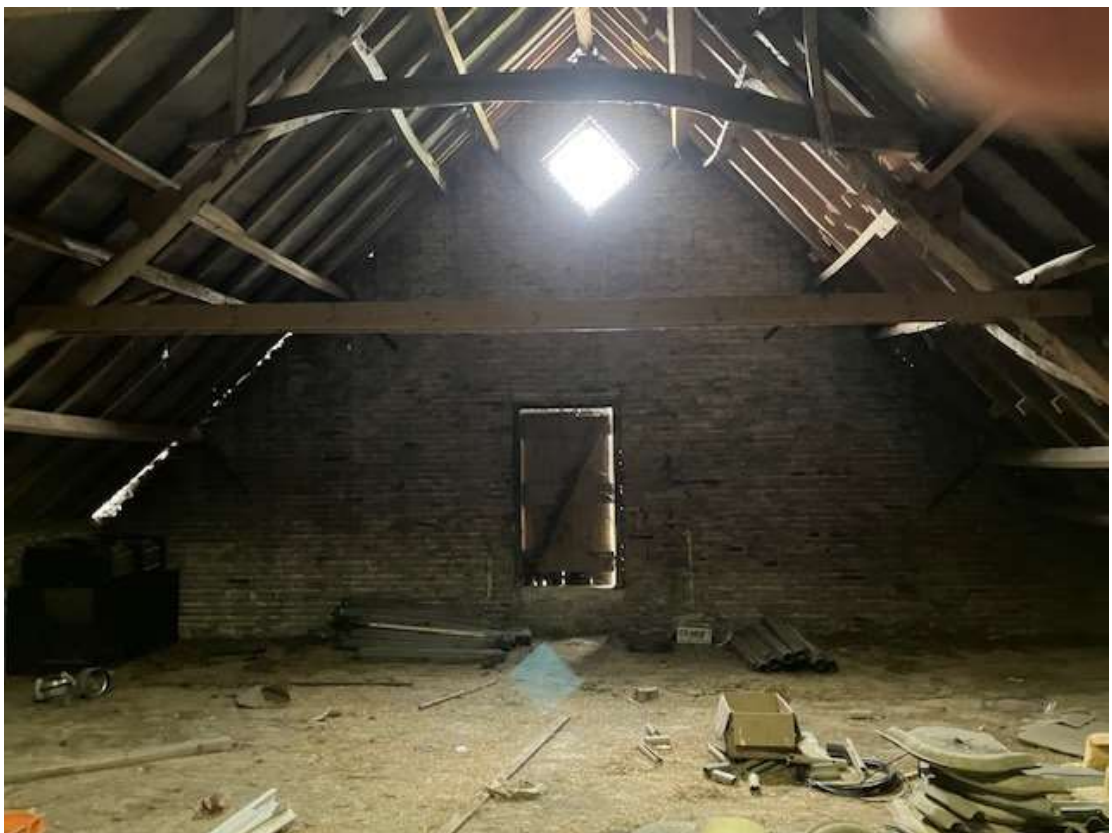
• Afbeelding 7: Kap boven het schuurgedeelte
