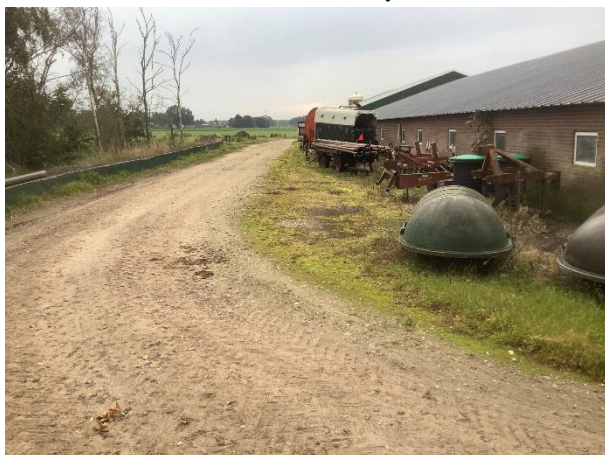
Foto 5 Foto van het met menggranulaat verharde pad
