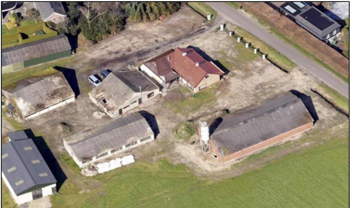
Afbeelding 3 Luchtfoto huidige situatie plangebied.
