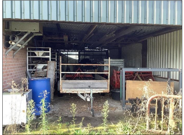
Foto 8 De aanbouw ten noorden van de loods kijkend naar het westen.
