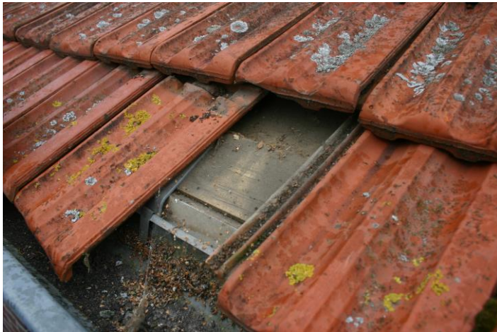
Figuur 4.4.1. De onderste rij dakpannen van het woonhuis liggen plat op een houten lat waardoor vogels niet onder de dakpannen kunnen komen.
