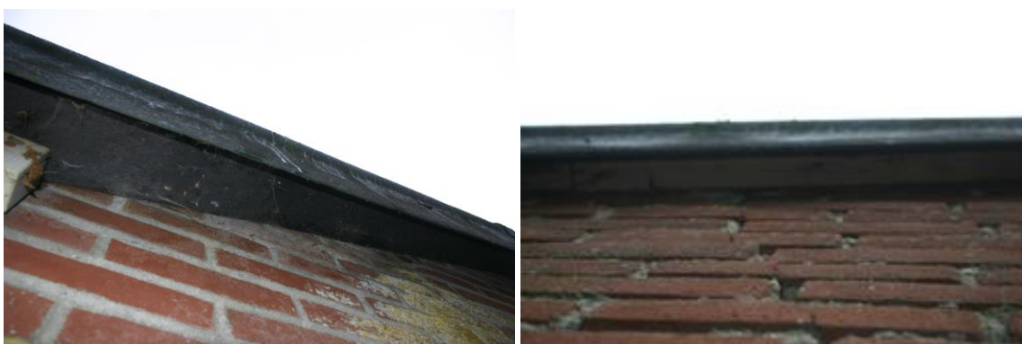
Figuur 4.4.4. De windveren op stallen 3 en 4 sluiten overal nauw aan, zodat vleermuizen hier geen toegang hebben.
