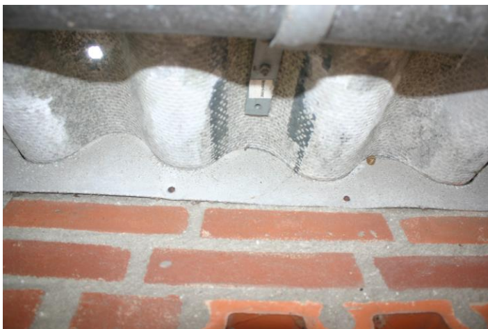
Figuur 4.4.2. Onder de golfplaten van stal 1 is vogelschroot aanwezig in de vorm van een metalen strip.
