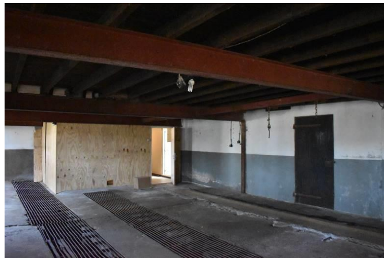
Bedrijfs gedeelte met stalen constructie.
