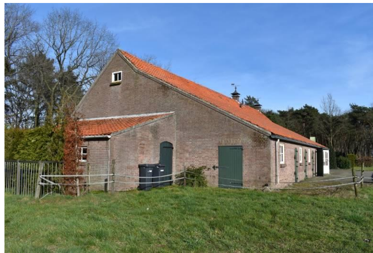
Rechterzijgevel gezien vanaf de achterzijde.
