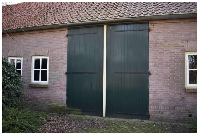
Dubbele staldeur in bedrijfsdeel.
