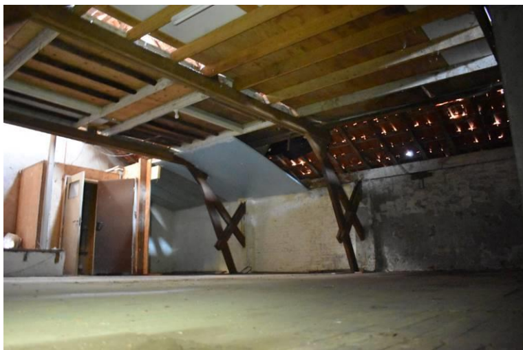
Bedrijfsdeel met houten spantconstructie.
