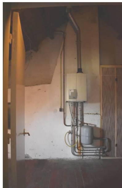
Verdieping met brandmuur en rookkanaal.
