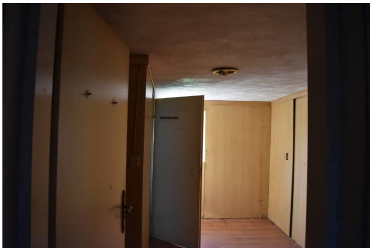
Bedrijfsgedeelte in uitbouw richting achtergevel.
