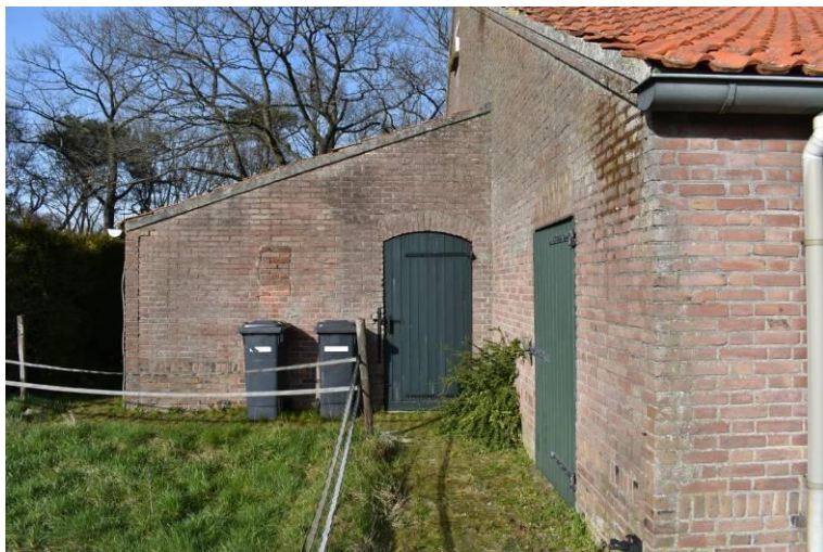
Achtergevel van de aanbouw.
