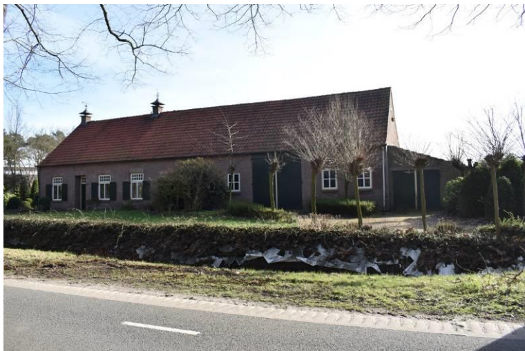
Voorgevel met rechts de aanbouw.
