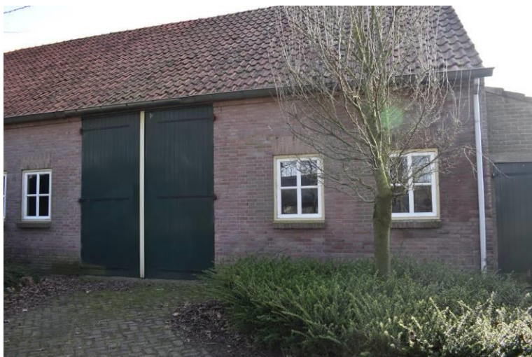
Voorgevel met rechts de aanbouw.
