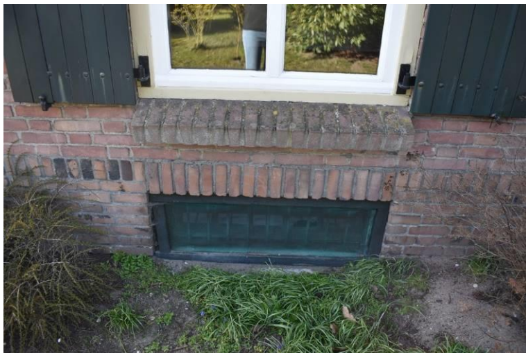
Keldervenster onder opkamer.
