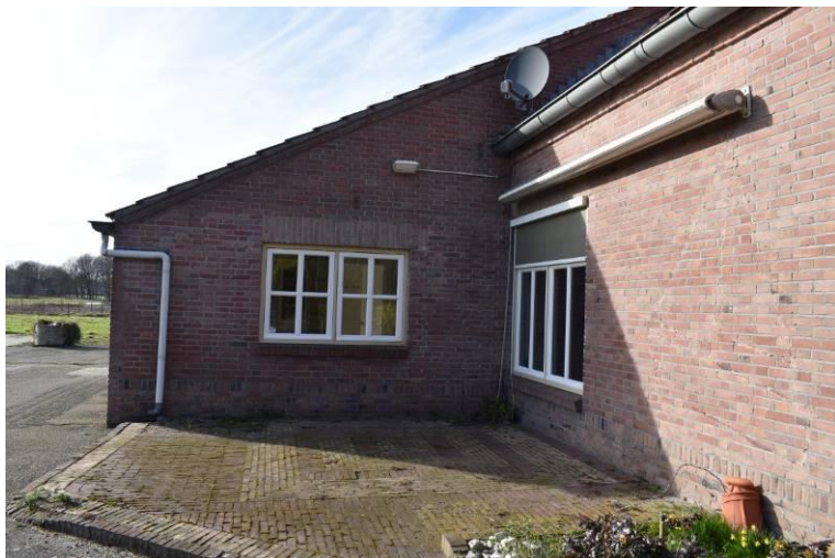
Linkerzijgevel van de aanbouw.
