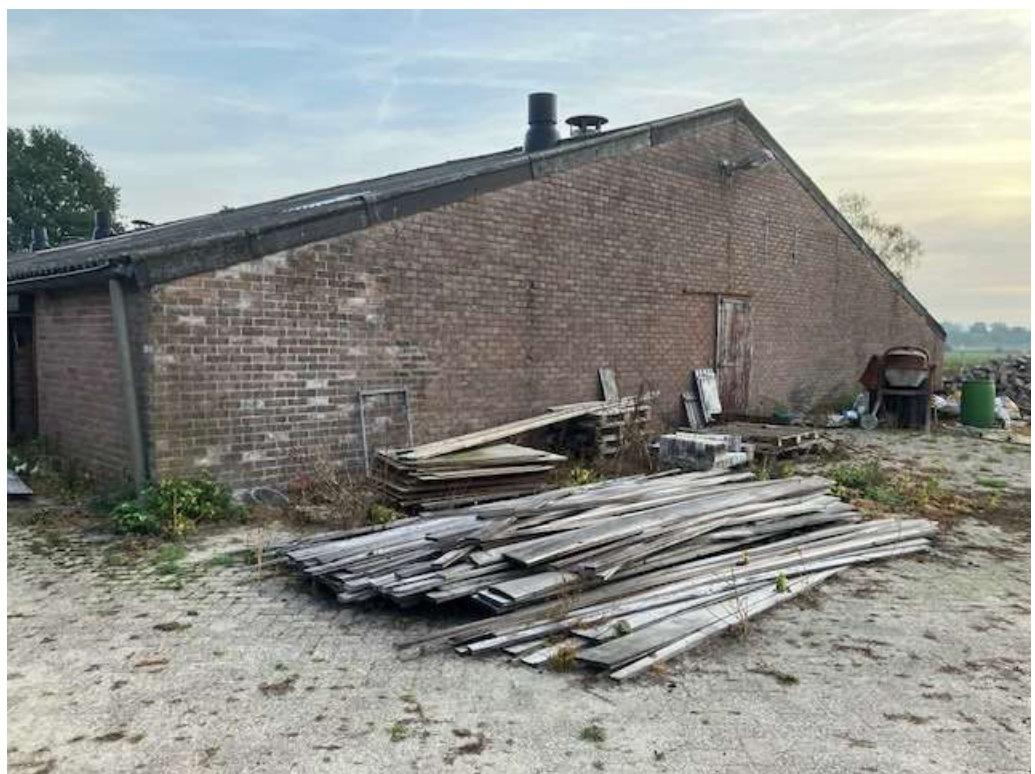
• Afbeelding 9: Achterzijde voorste stal, verharding en opslag stal inrichting.
