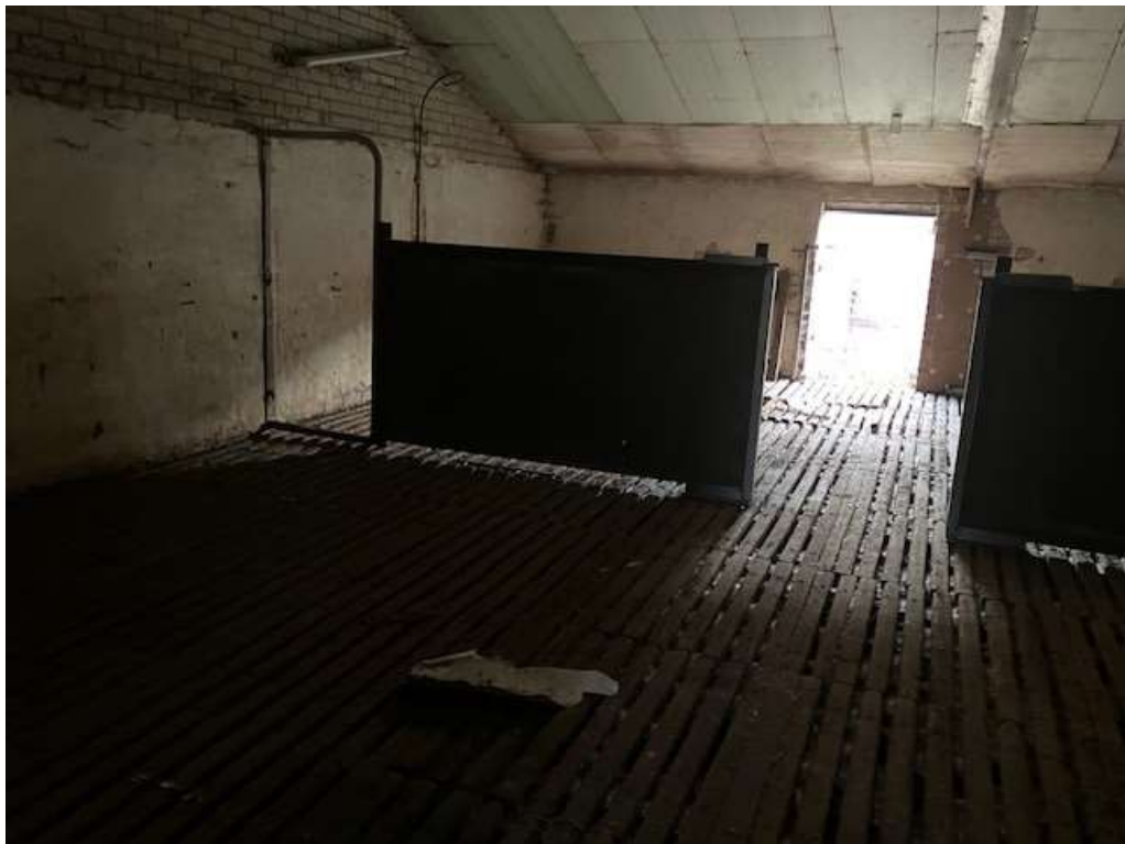
• Afbeelding 11: Binnenzijde stal, gedeelte hokinrichting nog aanwezig
