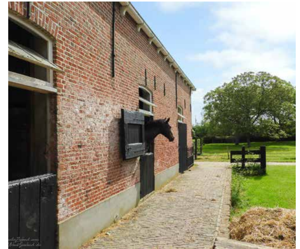
Plint van kasseien langs de oude schuur
