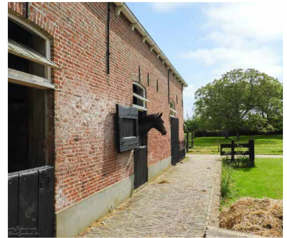
Plint van kasseien langs de oude schuur
