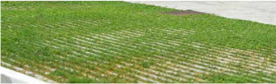
Grasbeton op de parkeerplaats
