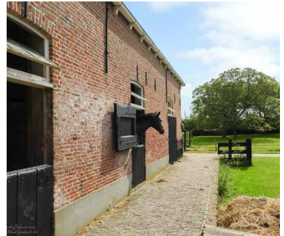
Plint van kasseien langs de oude schuur
