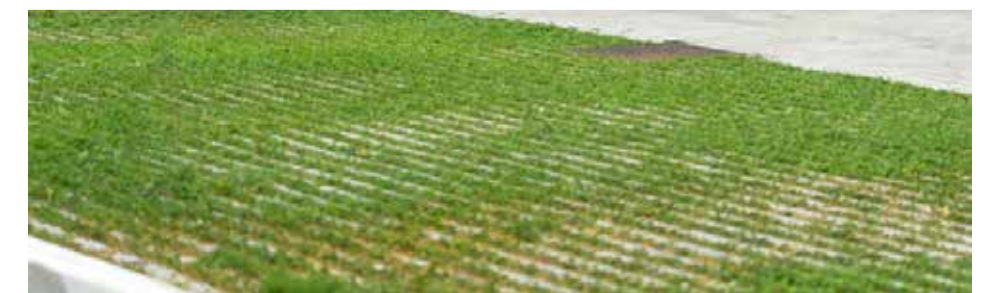
Grasbeton op de parkeerplaats
