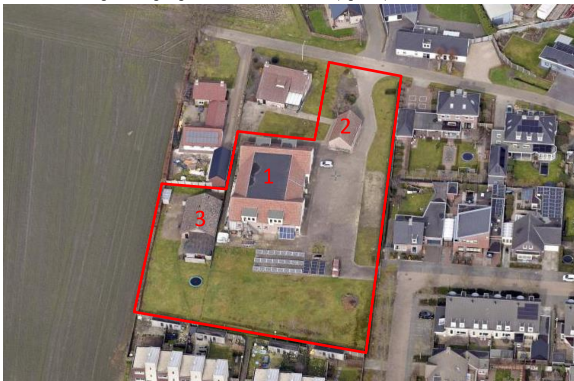
Figuur 4: luchtfoto onderzoekslocatie met een multifunctioneel gebouw (1), garage (2) en schuur met aanbouw (3).
