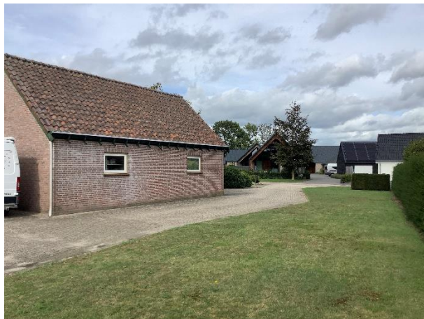
Foto 2 Foto richting de Vossenweg (noordzijde)
