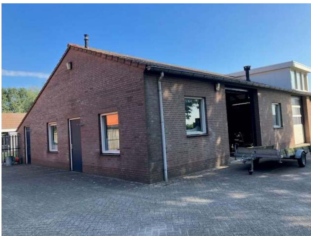
• Afbeelding 10: Bijgebouw, dakkapel wordt verwijderd
