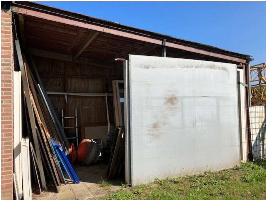
• Afbeelding 12: Aanbouw achter bijgebouw, wordt gesloopt
