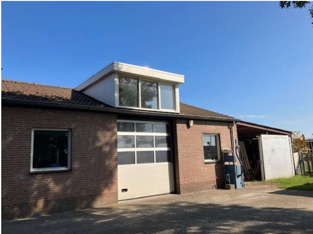
• Afbeelding 11: Dakkapel en aanbouw achter bijgebouw worden verwijderd
