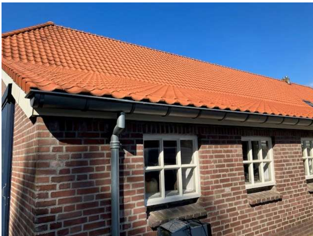
• Afbeelding 9: Dak 5 jaar oud, alles dicht gemaakt met vogelschroot
