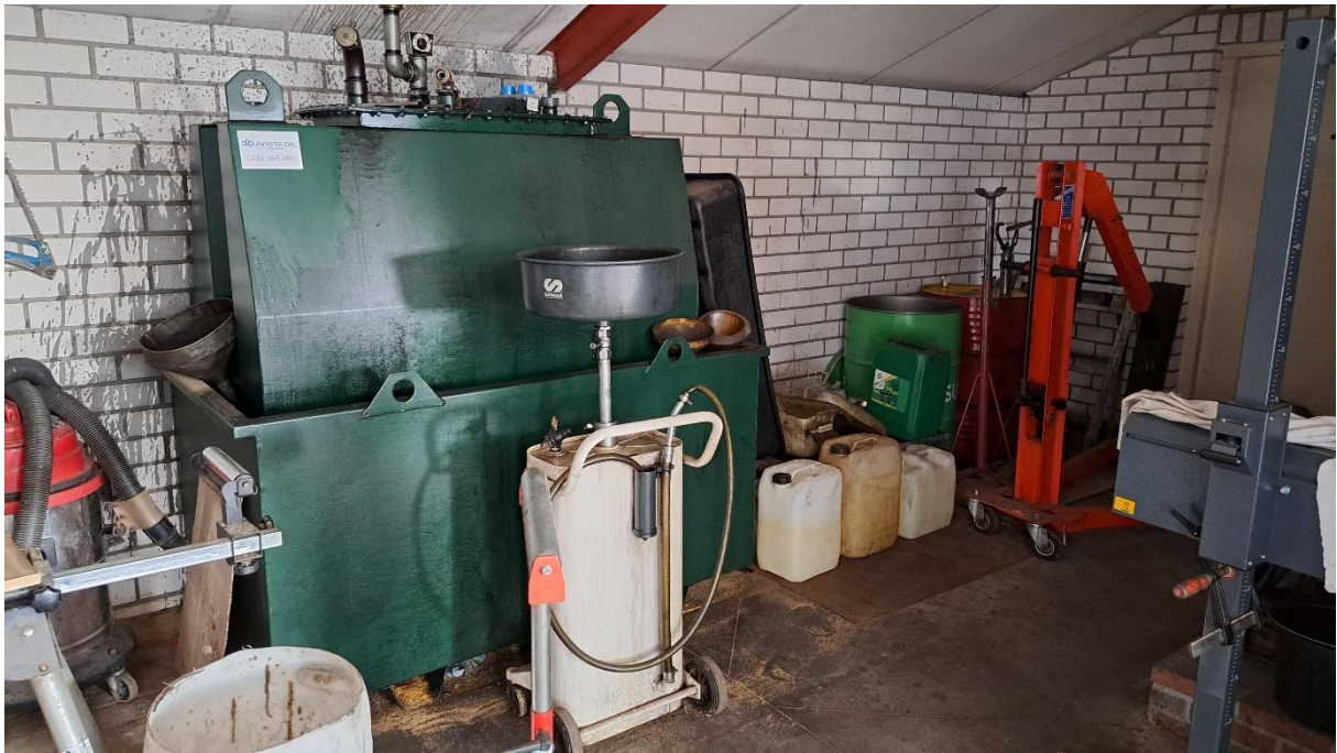
olieopslag schuur 1 (bij meetpunt 5)
