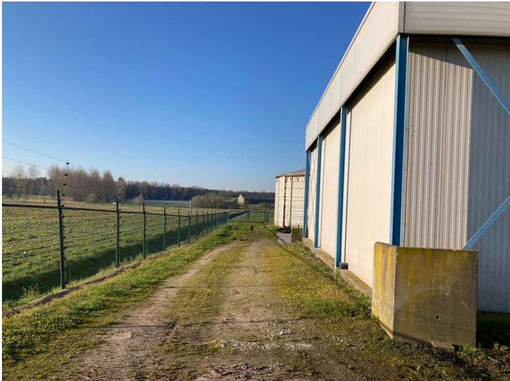
• Afbeelding 10: Zijgevel achterste koelcel en elektrische afsterking wordt ook gesloopt
