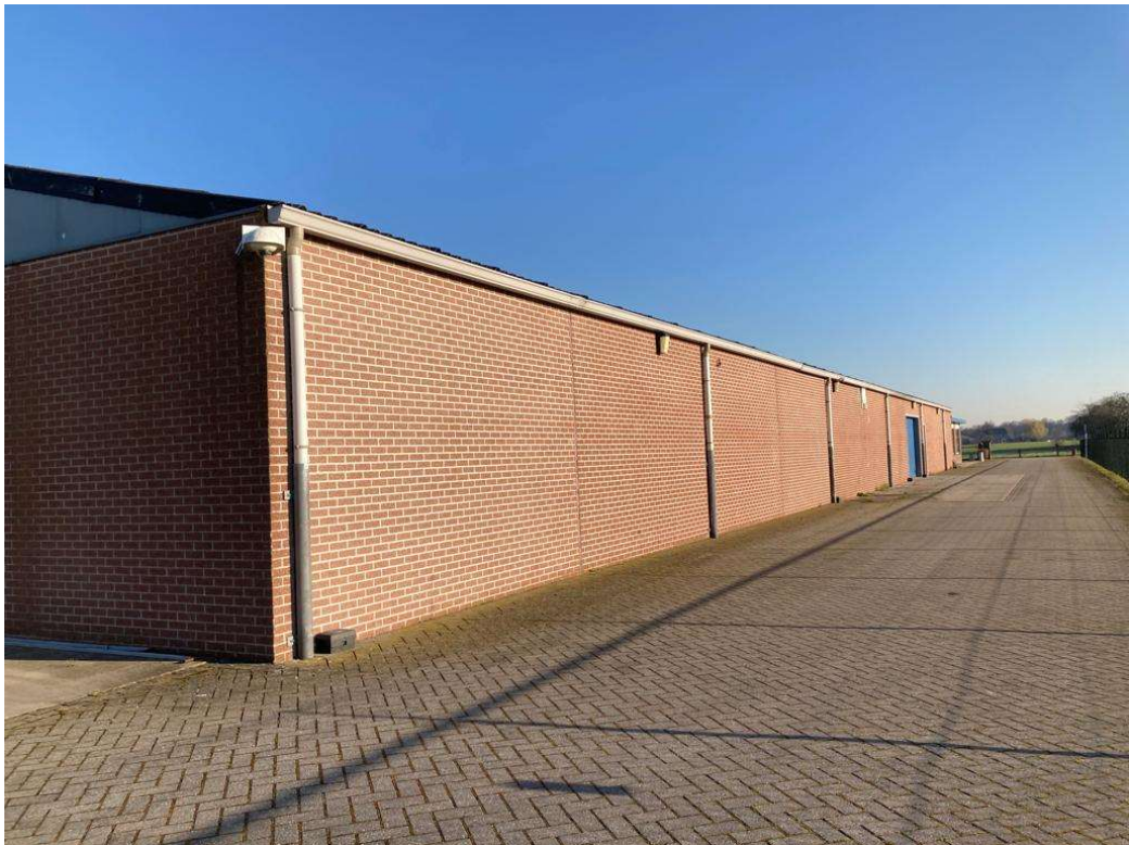
• Afbeelding 5: Dit gedeelte wordt verbouwd
