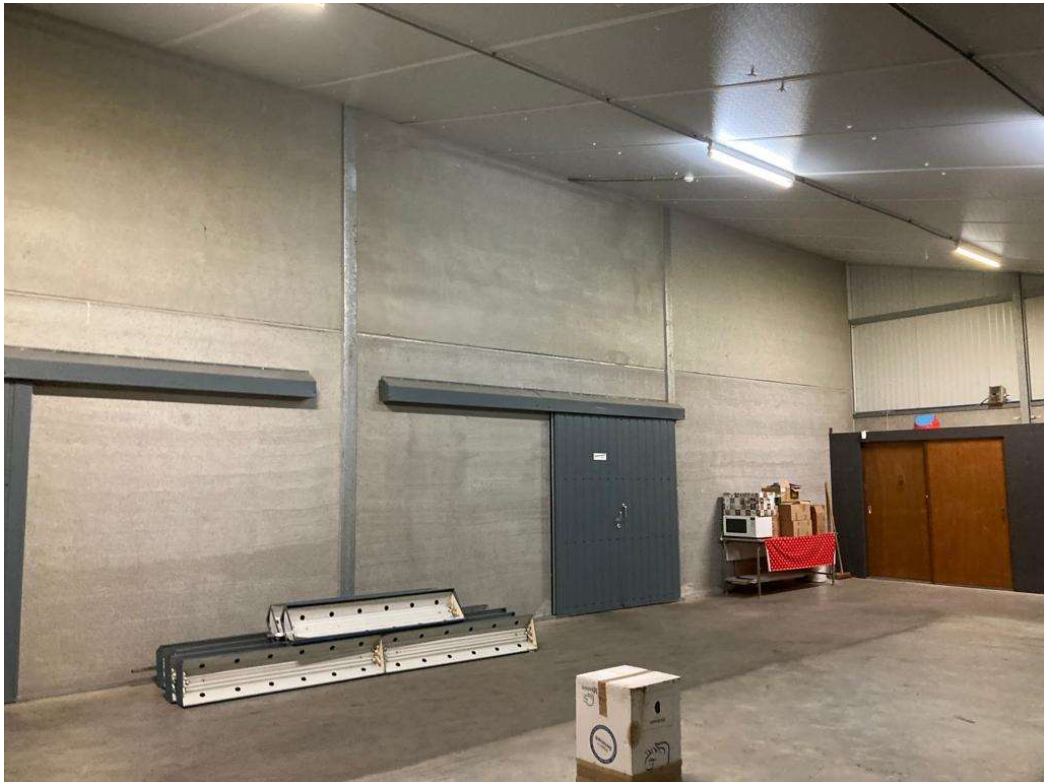
• Afbeelding 16: binnenzijde te slopen bedrijfsruimte
