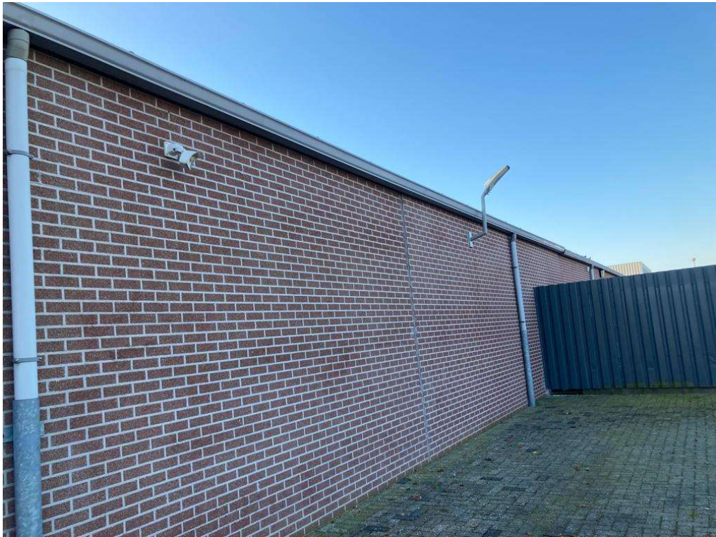
• Afbeelding 4: Te slopen gebouw
