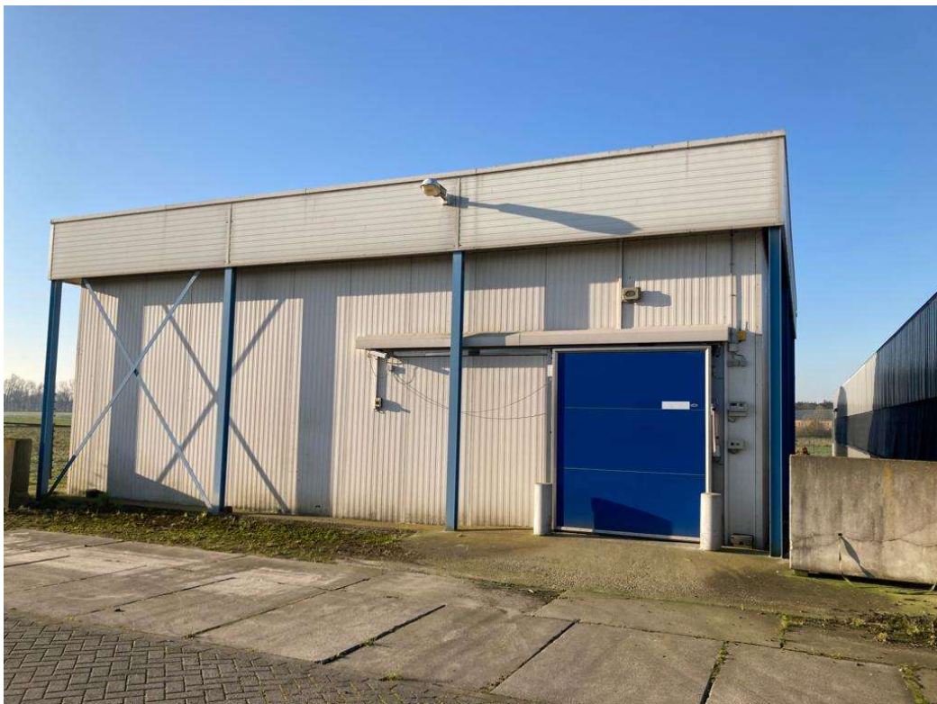
• Afbeelding 11: Voorgevel achterste koelcel
