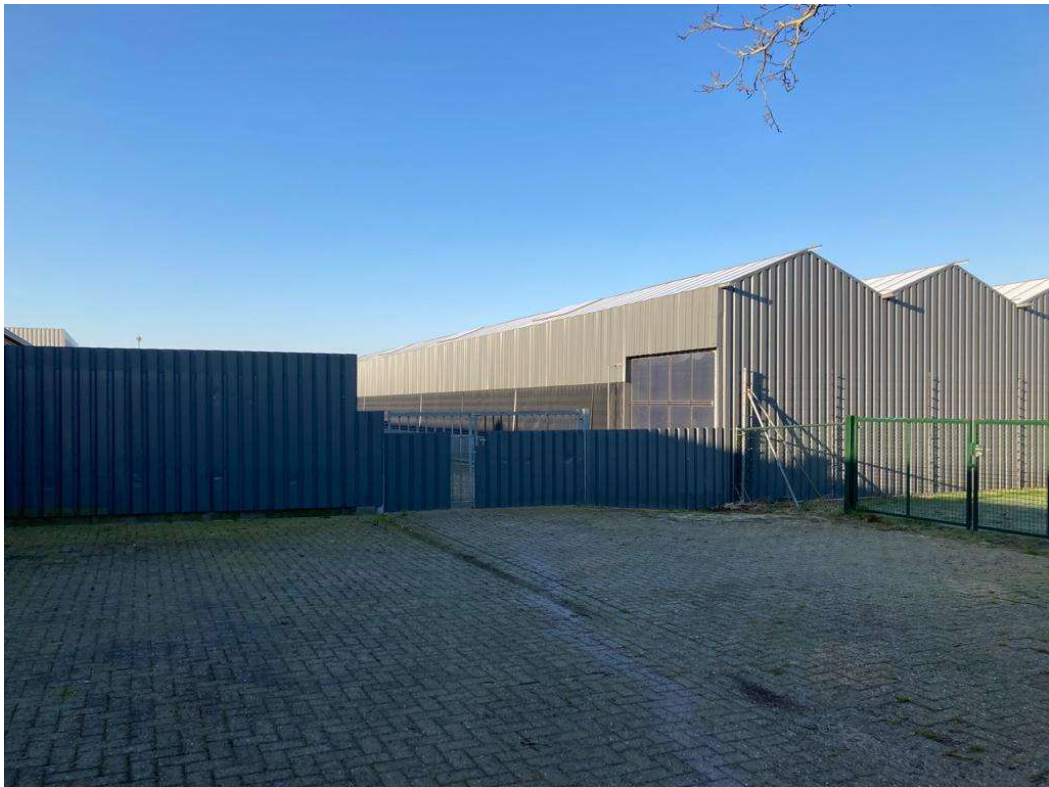
• Afbeelding 3: Zicht op te slopen gebouwen
