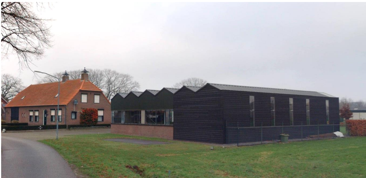
Figuur 2.2.2: Zicht op het te handhaven voormalige agrarische bedrijfsgebouw, gezien vanaf de Rodegraafweg (bron: streetsmart.cyclomedia.com).
