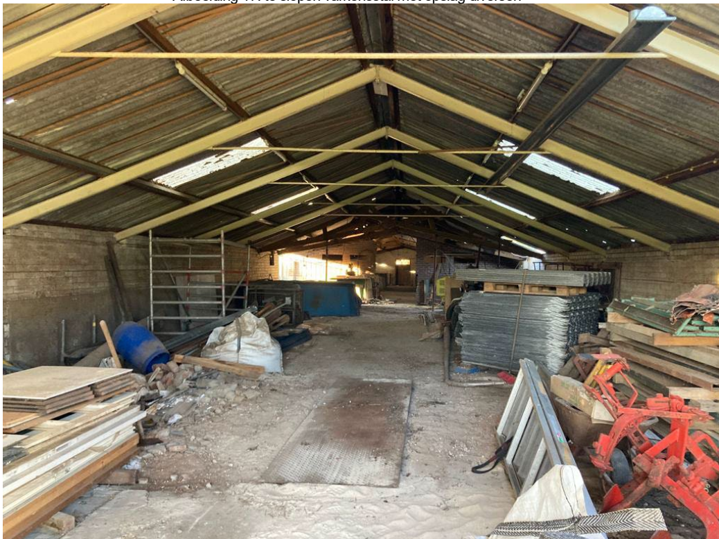
• Afbeelding 17: te slopen varkensstal met opslag diversen
