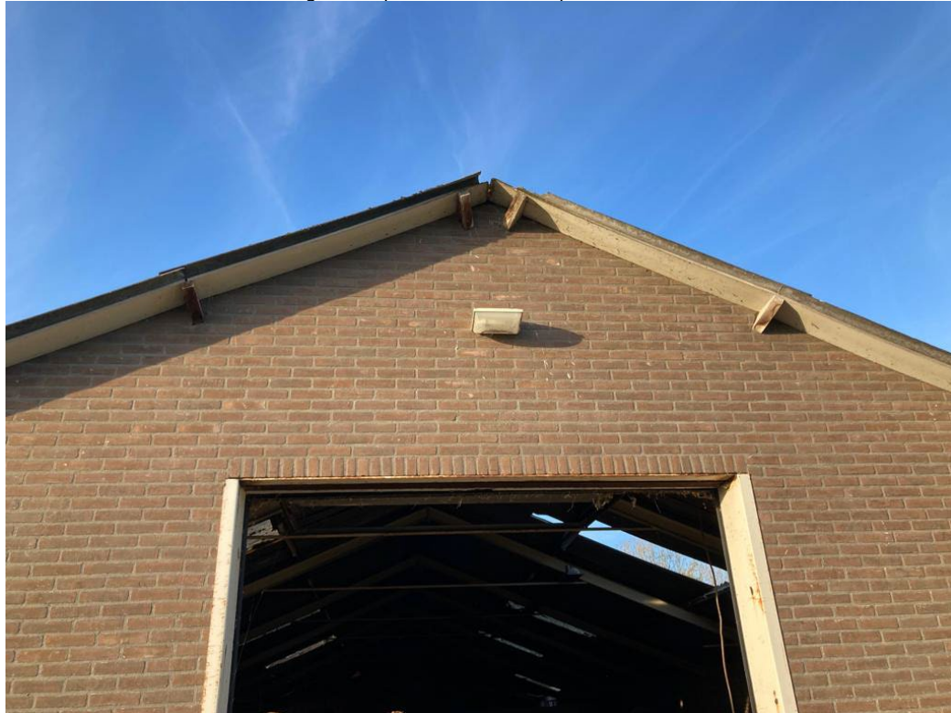
• Afbeelding 3: te slopen schuur met oud spreeuwennest in de nok
