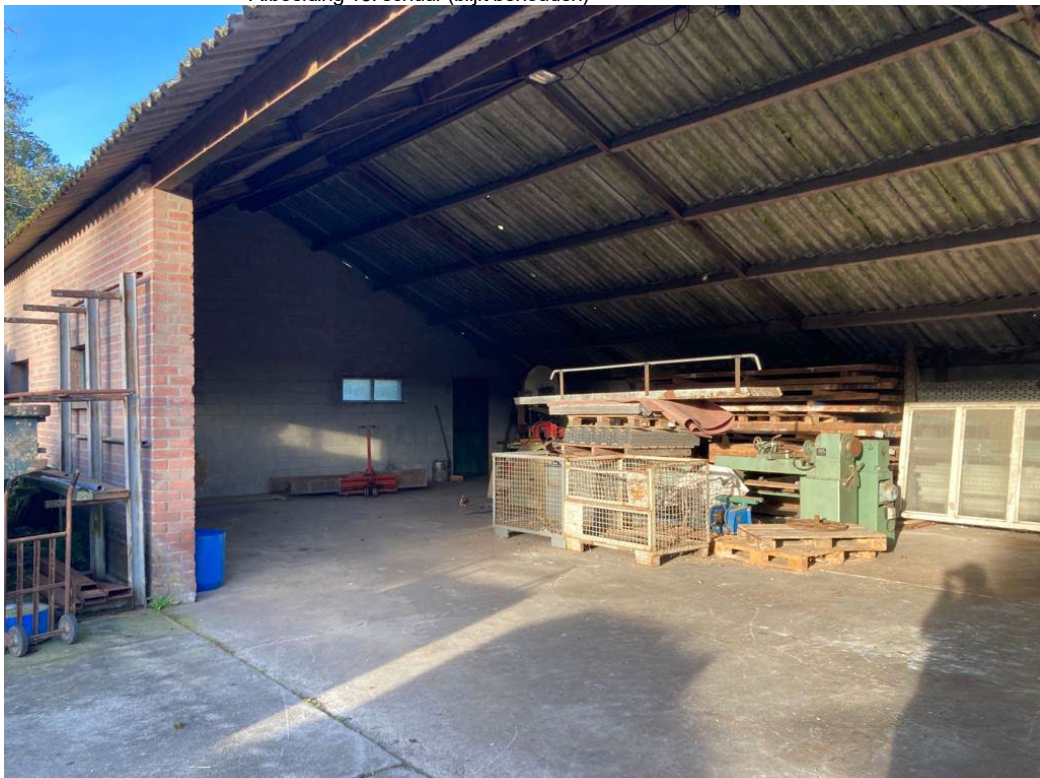
• Afbeelding 13: schuur (blijft behouden)
