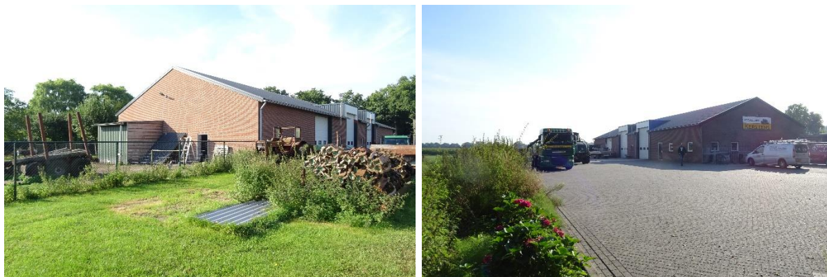
Afbeelding 5 en 6: bestaande aangrenzende bedrijfsloods, welke gecontroleerd is op de aanwezigheid van beschermde soorten flora en fauna. Bron: R.J.L. Bijvelds 14-09-2021
