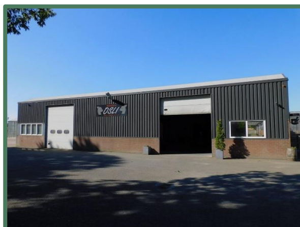
Overzicht te slopen loods
