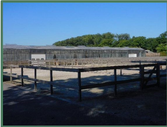
Te slopen kassen
