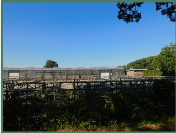
Te slopen kassen
