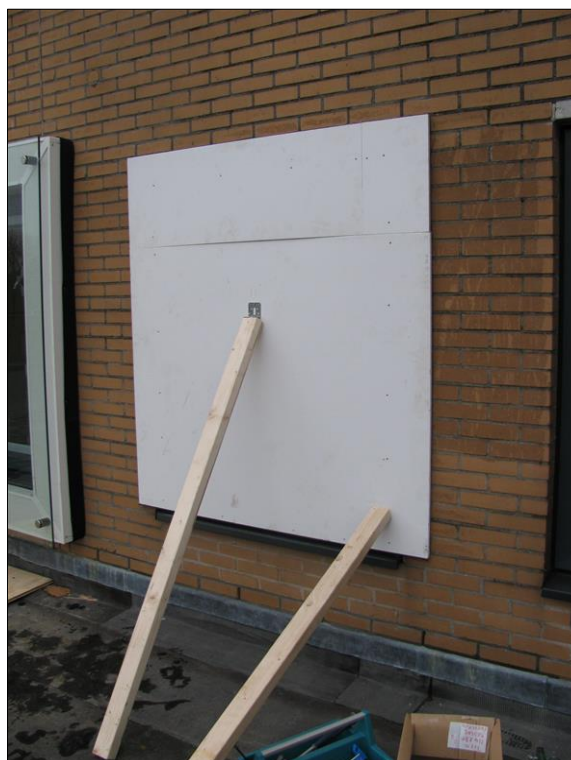
Foto II.4 Provisorische afdichting tweede raam
