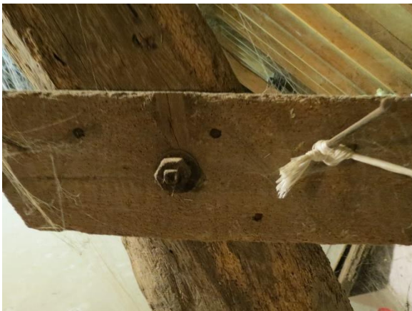
Afb.26. Een aantal delen is vastgezet met 'moderne' verbindingstechnieken, vermoedelijk omstreeks 1926.
