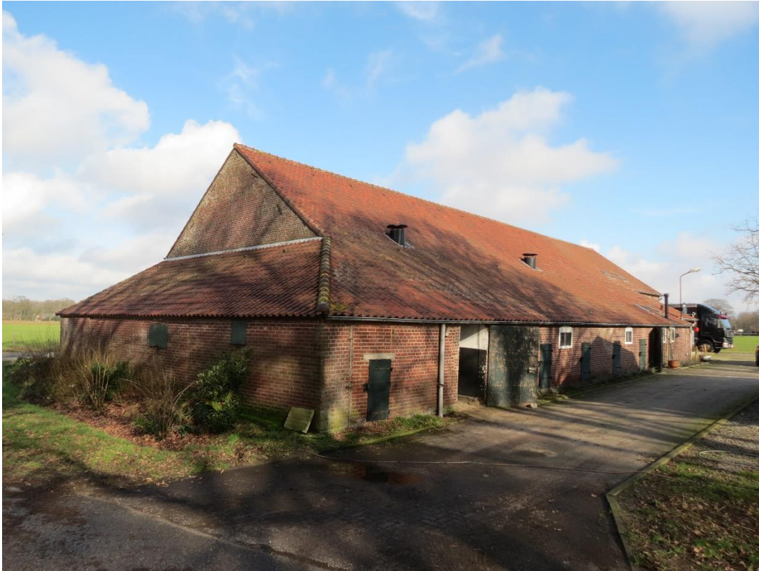
Afb.3 Rechter zijgevel en achtergevel ter hoogte van het stalgedeelte.
