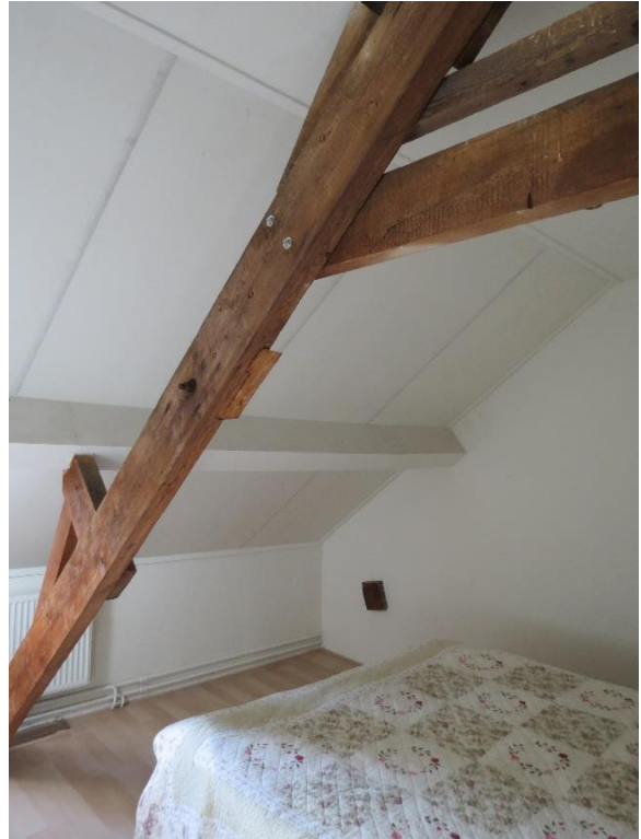
Afb.13. De onderste ligger van het gebint uit 1926 is recentelijk omhooggebracht.
