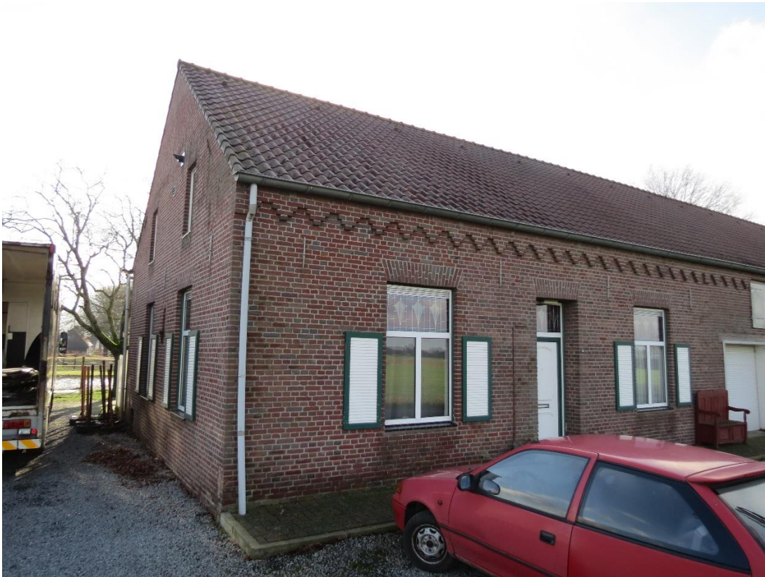
Afb.1. Linker zijgevel en voorgevel ter hoogte van het woongedeelte.
