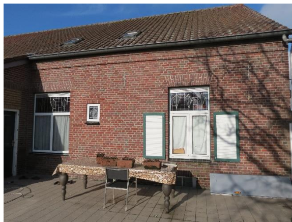
Afb.5. Achtergevel van het woongedeelte.
