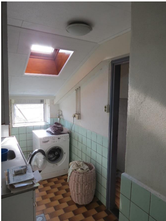
Afb.14-15. Tussendeel met washok en paneeldeur.
