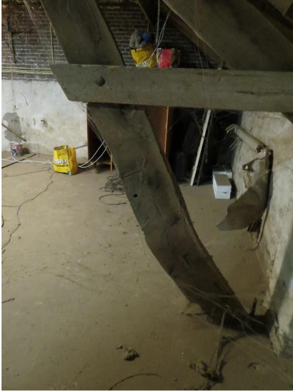
Afb.24-25. De gebinten vertonen diverse sporen van oude pen-en-gatverbindingen.
