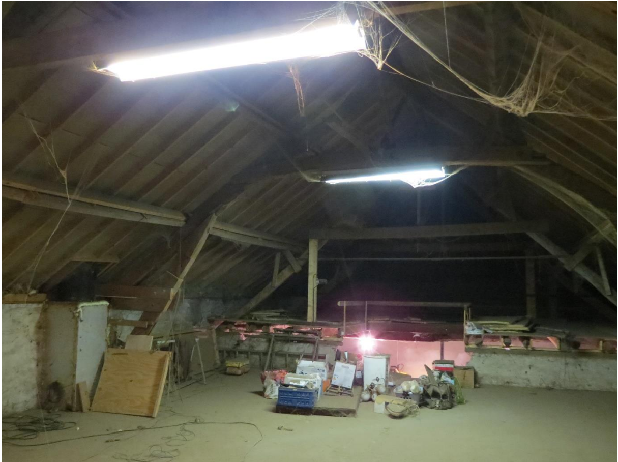
Afb.21. Zolder boven het bedrijfsgedeelte, gezien richting wagenberging. De vloer boven het stalgedeelte ligt lager is van beton. Het dak is vernieuwd.
