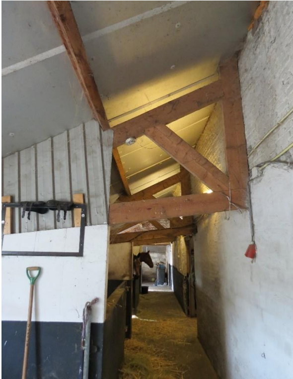
Afb.16. Lage uitbouw aan de achterzijde, met vernieuwd dak- en spantconstructie.
