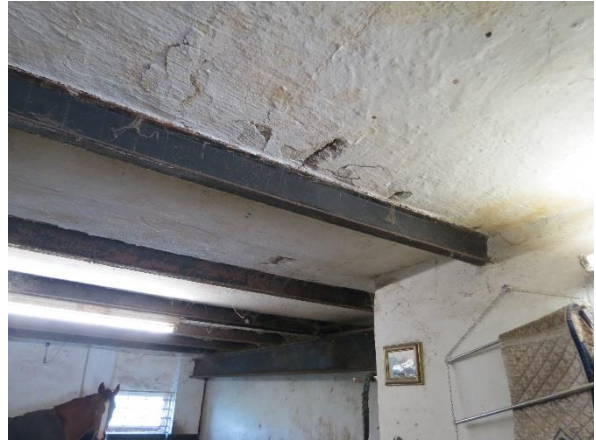
Afb.17. Stal: betonnen plafond op stalen H-balken.
