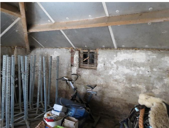
Afb.20. Uitbouw aan de rechterzijde. Ook hier is het dak vernieuwd.
