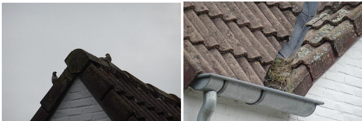
Afbeelding 13 en 14: aanwezige huismussen op het dak en nestelmateriaal in de dakgoten. Bron: Rik Bijvelds. Datum: 15-06-2021
