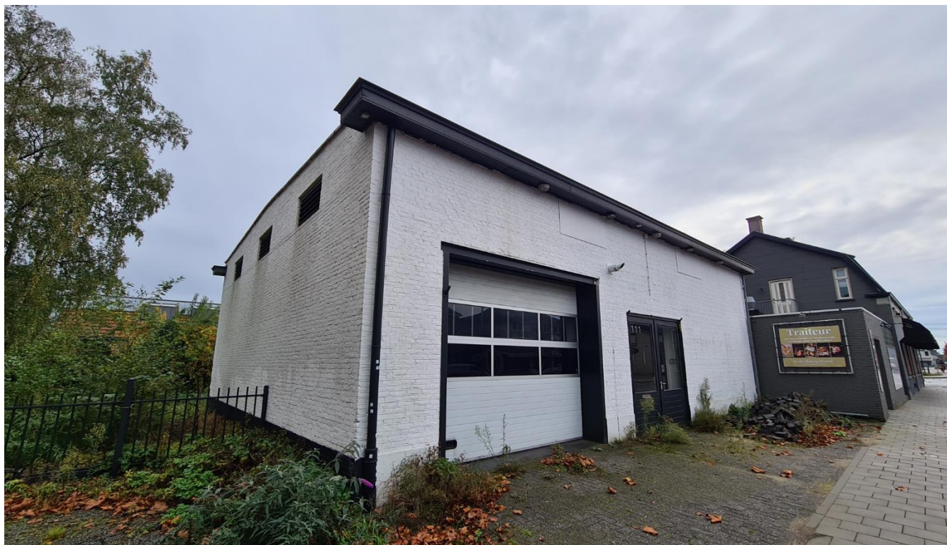
Figuur 4: Bedrijfspannd tegen de zuidwestgrens van het plangebied, gezien vanaf de Stationsstraat
