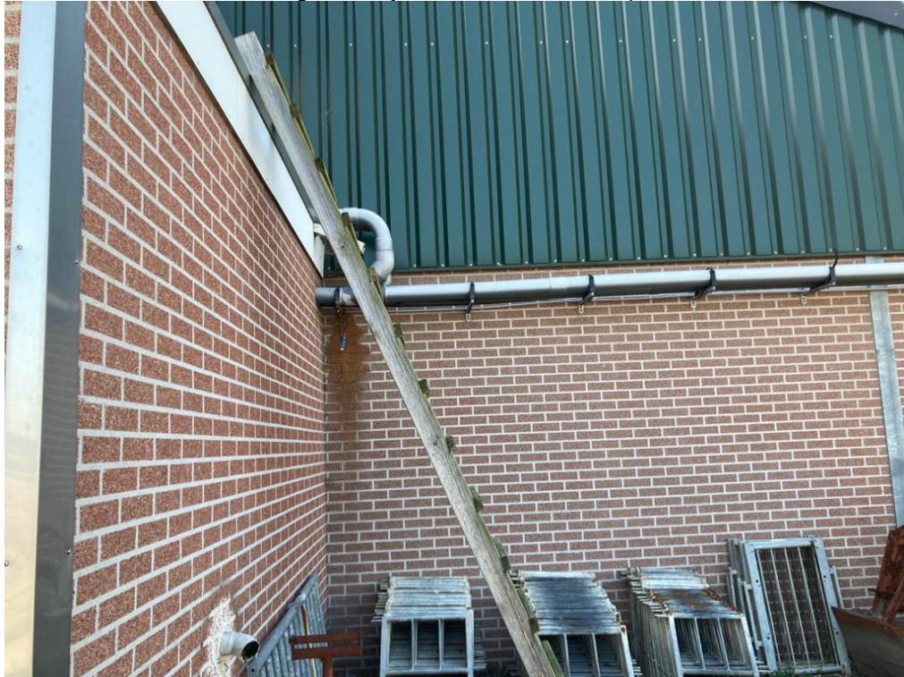
• Afbeelding 9: buitenzijde varkensstal met damwandprofiel
