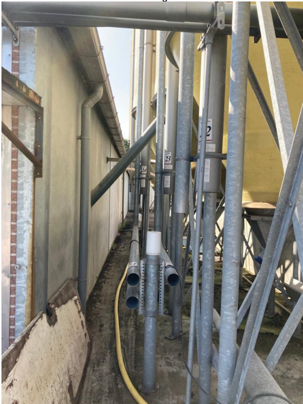
• Afbeelding 10: ruimte tussen de stal en voersilo's
