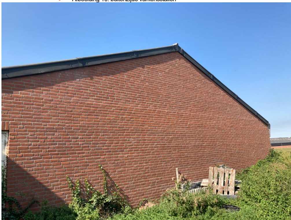
• Afbeelding 10: buitenzijde varkensstallen
