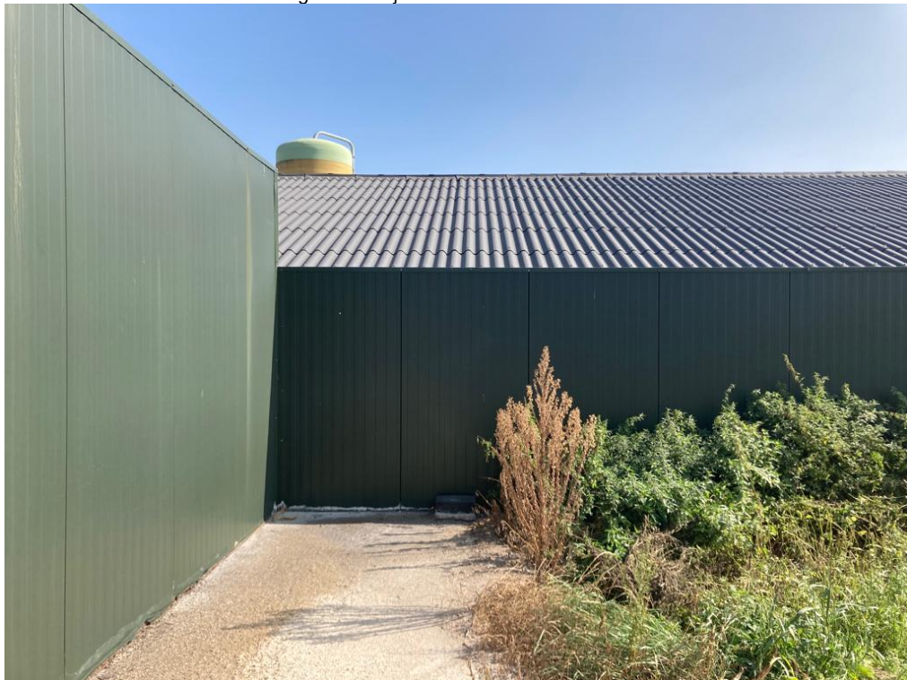
• Afbeelding 7: buitenzijde varkensstallen
