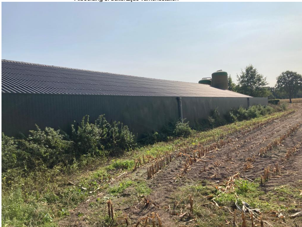
• Afbeelding 8: buitenzijde varkensstallen
