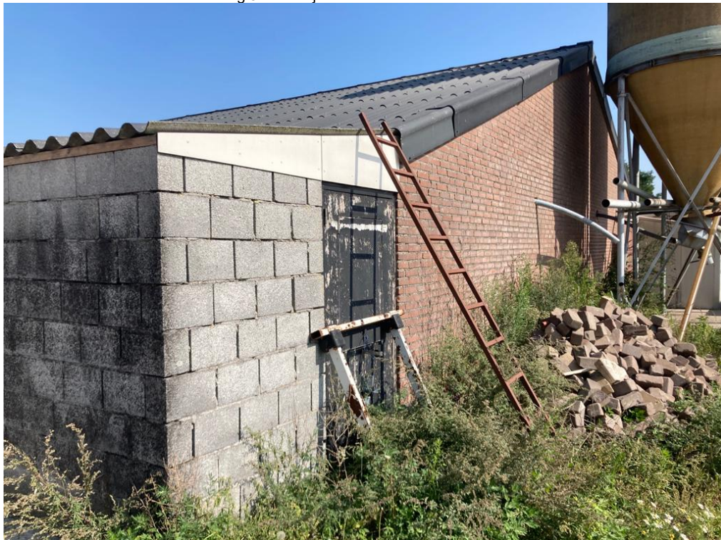
• Afbeelding 5: buitenzijde varkensstallen
