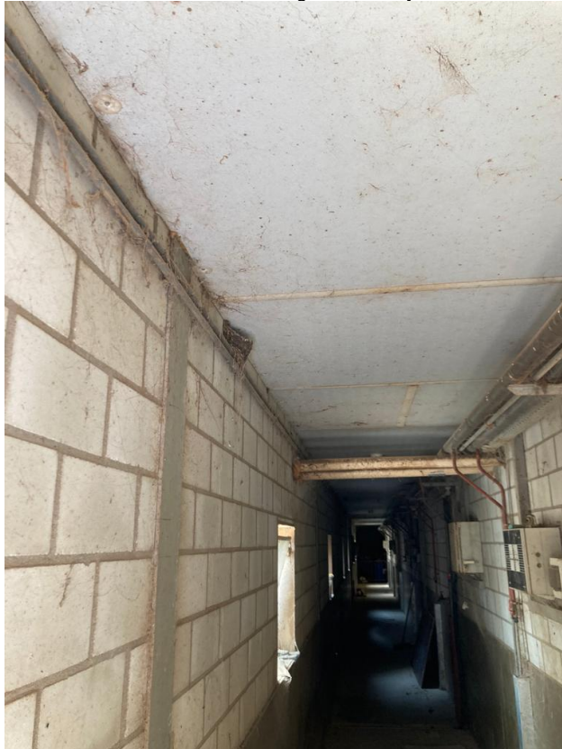
• Afbeelding 15: binnenzijde varkensstallen
