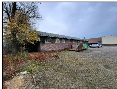
Figuur 4. Achterzijde gebouw op onderzoekslocatie, kijkrichting zuidwesten.
