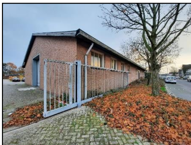
Figuur 3. Impressie gebouw op onderzoekslocatie, kijkrichting noordoosten.
