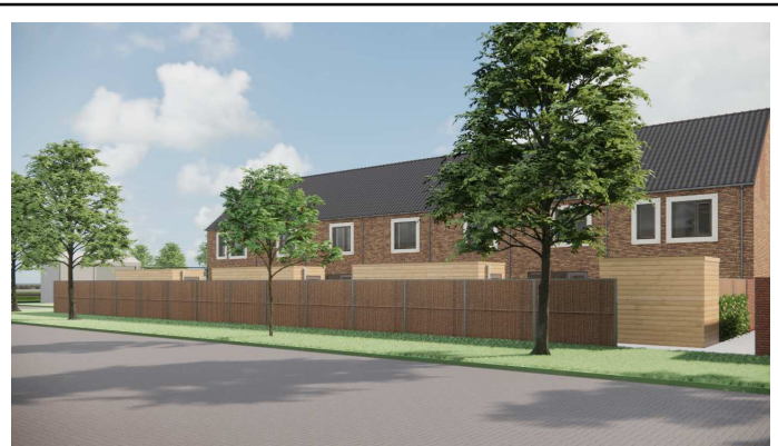
figuur 3, geluidscherm blok D, Kokowall-Lite geluidscherm, zijde openbaar groen
