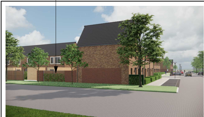
figuur 2, geluidscherm blok A, op as A.1 metselwerk en Kokowall-Lite geluidscherm
