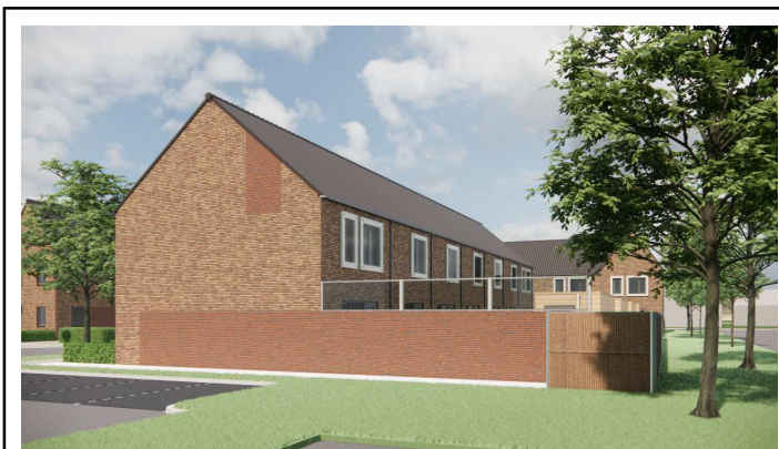
figuur 6, geluidscherm blok D, op as D.8 metselwerk en glazen geluidscherm
